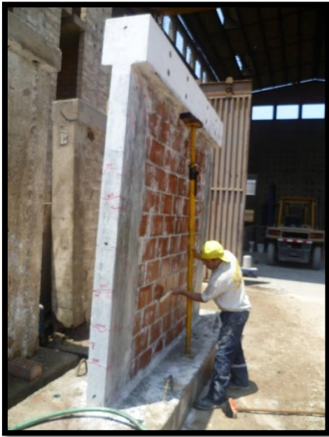
Figura 33. Apuntalamiento de viga solera y limpieza de escombros (izquierda)
