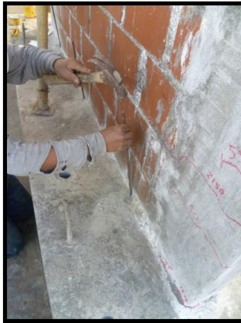
Figura 3.24. Colocación de aceros para anclaje de muro.
