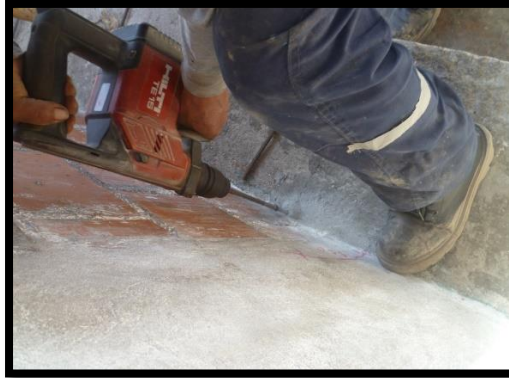
Figura 3.22. Perforación de la base del muro para anclaje de malla a cada 70 cm.
