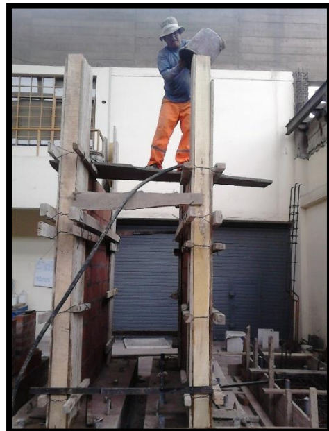
Figura 25. Vaciado y vibrado de concreto en columnas
