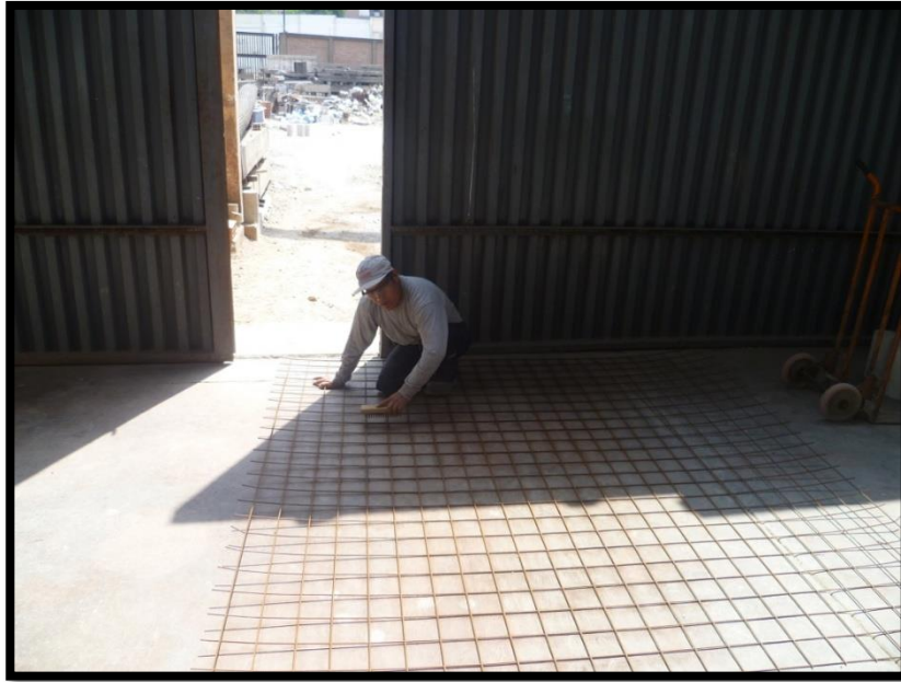
Figura 37. Malla electrosoldada de 1/4" para encamisado de muro
