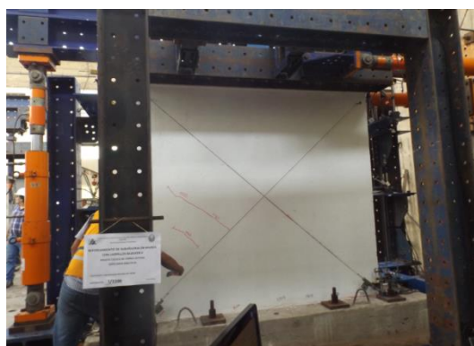
Foto 3. Grietas diagonales en el muro de la cara reforzada para una distorsión 1/1100
