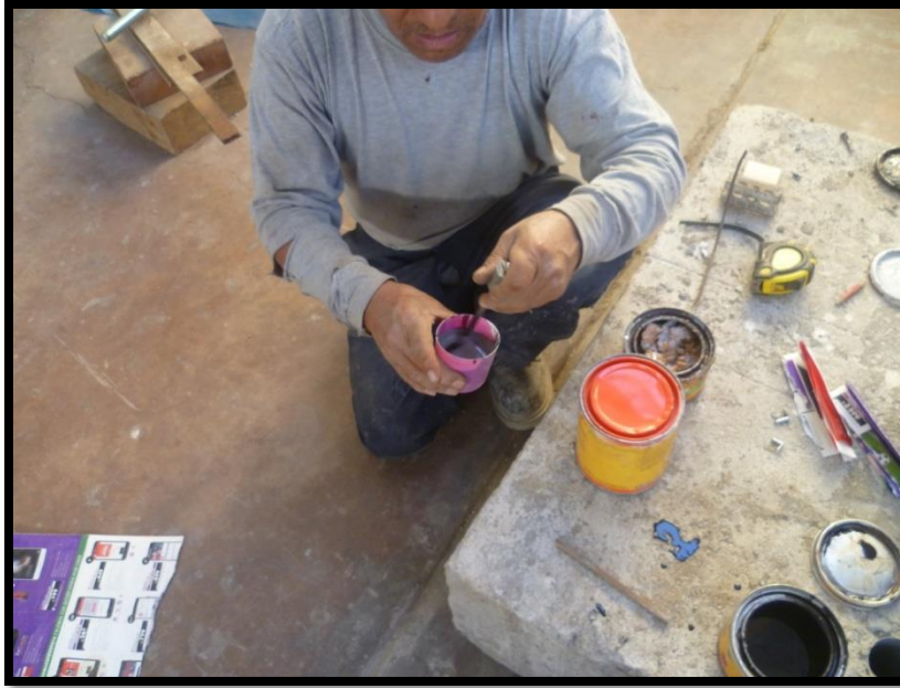
Figura 45. Mezcla epoxica sikadur 32 proporción 1:2 para fijación de anclajes
