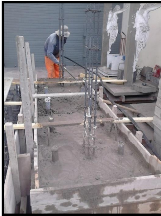
Figura 3.10. Vaciado y vibrado de concreto en base de muro.
