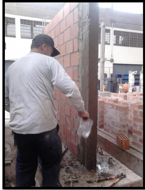
Figura 27. Curado de columnas
