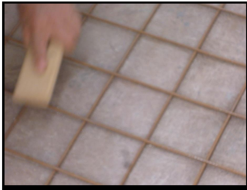
Figura 38. Limpieza de óxido en malla electrosoldada de 1/4"
