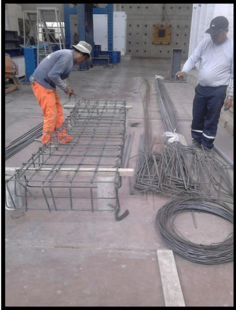
Figura 15. Se empieza con la habilitación del acero para la base de cimentación.
