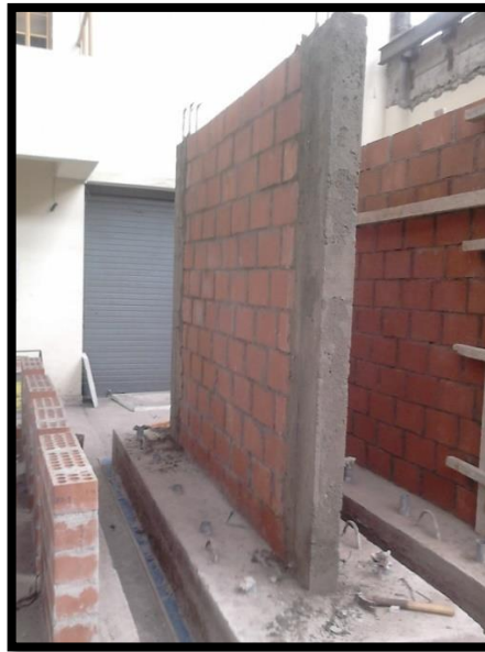
Figura 3.13. Encofrado, vaciado y desencofrado de columnas de confinamiento después de 24 horas.
