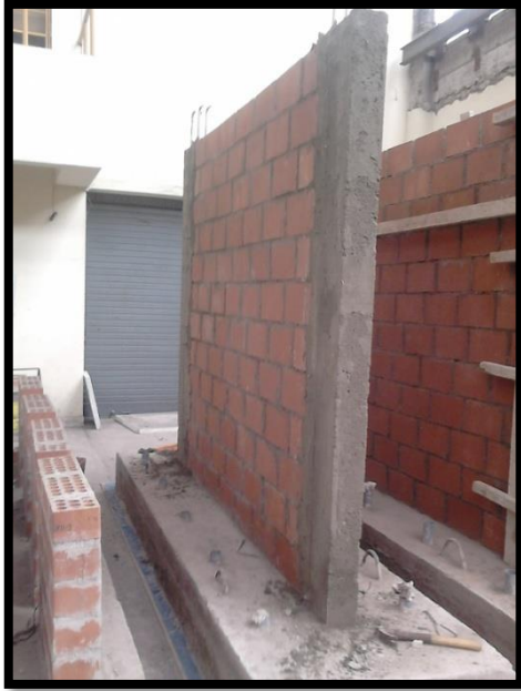
Figura 26. Desenfofrado de columnas
