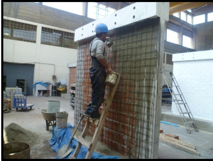
Figura 49. Lechada de cemento para relleno de grietas en muro
