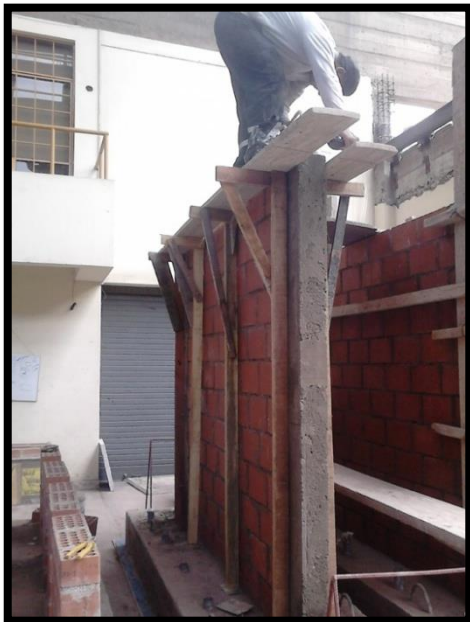
Figura 28. Encofrado para viga solera de muro
