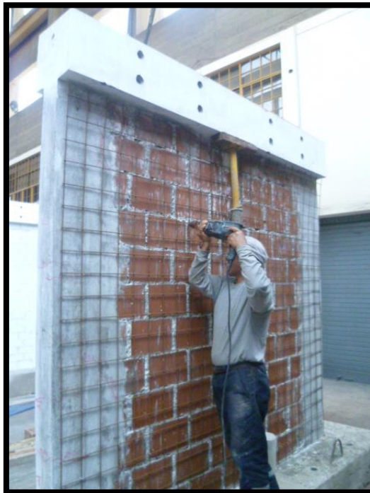
Figura 42. Perforación de muro para aceros de fijación
