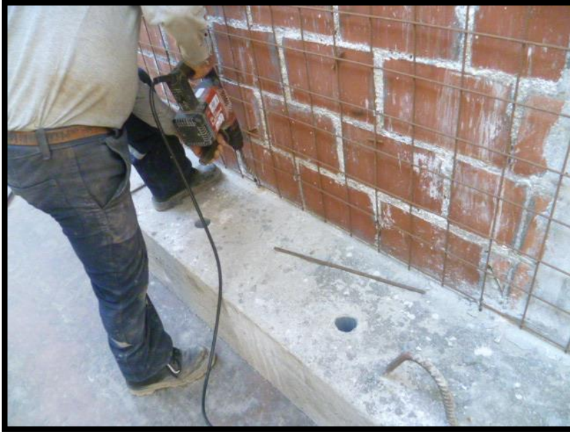
Figura 43. Perforación en la base para anclaje de malla electrosoldada
