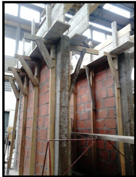
Figura 29. Se continúa con el encofrado de viga solera para muro
