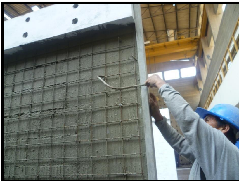
Figura 50. Alineación lateral para tarrajeo de muro
