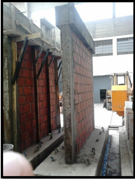
Figura 30. Desencofrado de viga solera
