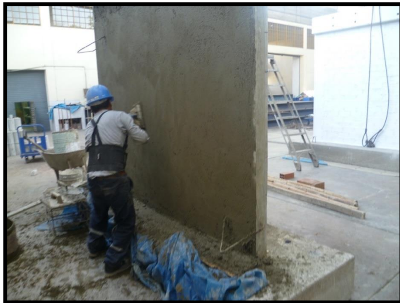
Figura 52. Acabado final de tarrajeo de muro
