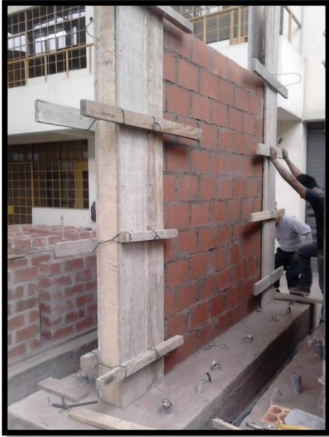
Figura 22. Encofrado de columnas para confinamiento del muro
