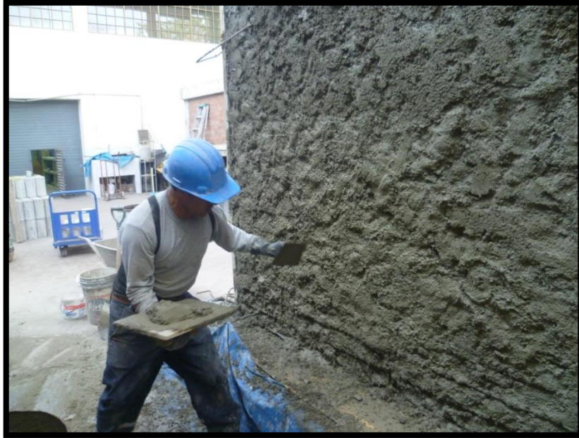
Figura 51. Tarrajeo de muro reparado y reforzado
