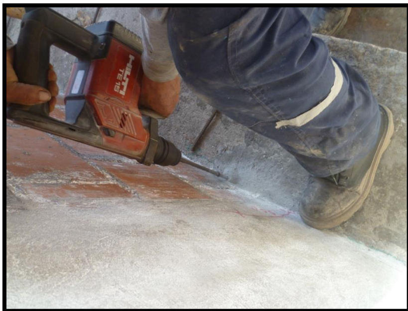
Figura 44. Se perfora cada 70 cm. para anclaje de malla
