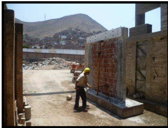
Figura 35. Limpieza de escombros (izquierda)
