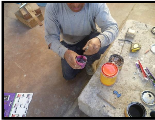
Figura 3.23. Mezcla epóxica sikadur 32 proporción 1:2 para fijación de anclajes.
