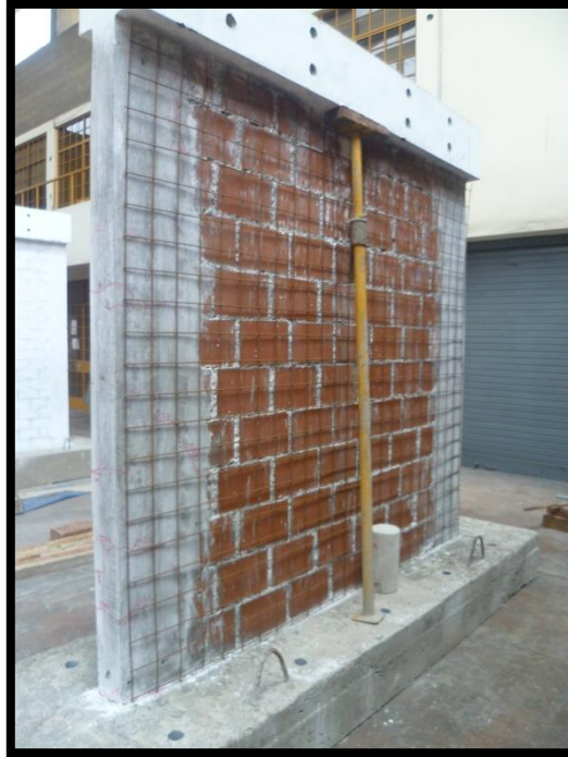
Figura 39. Reforzamiento de muro con malla electrosoldada de 1/4''
