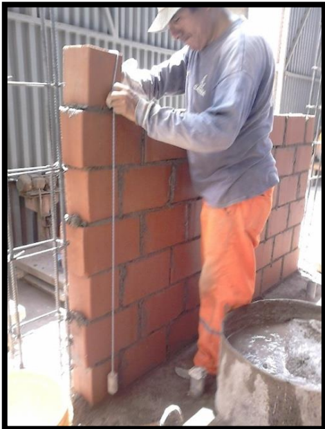
Figura 20. Alineación de ladrillo blocker II con plomada
