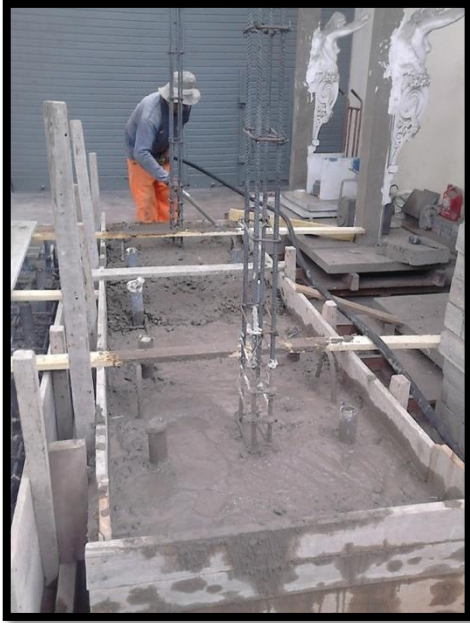
Figura 19. Vaciado y vibrado de concreto
