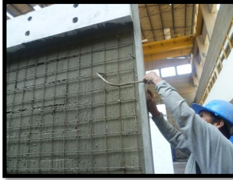
Figura 3.26. Alineación lateral para tarrajeo de muro.
