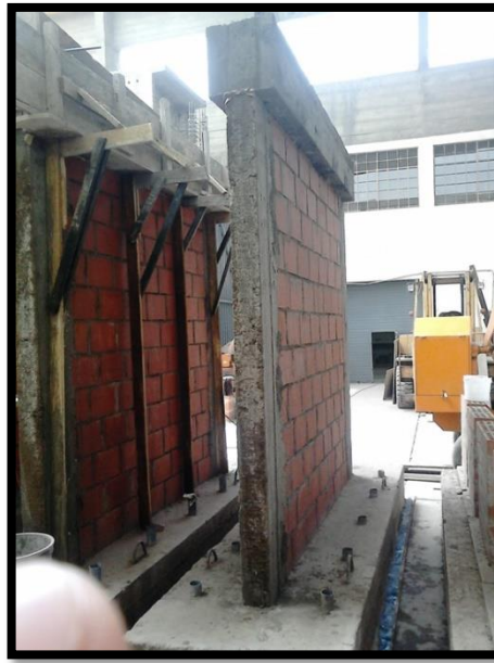
Figura 3.14. Encofrado, vaciado y desencofrado de viga solera después de 24 horas.
