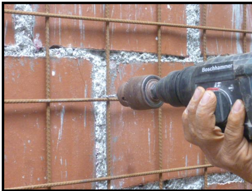
Figura 40. Perforación en muro para colocación de aceros de fijación
