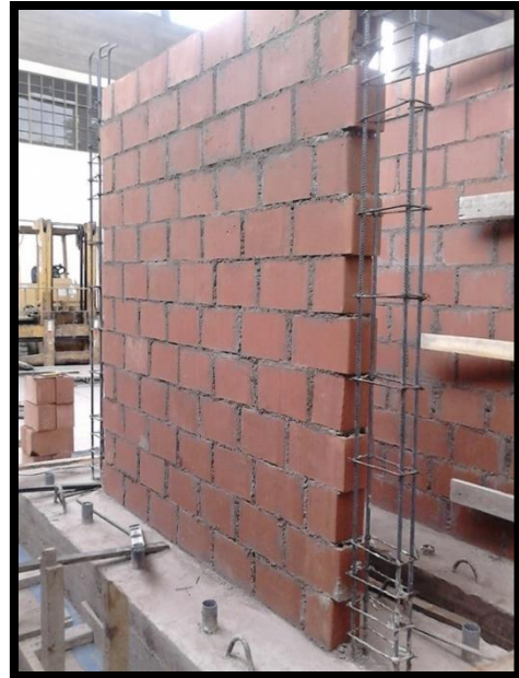
Figura 21. Dentado del muro para amarre de columnas de confinamiento
