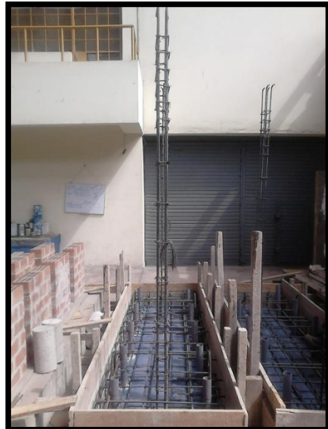
Figura 18. Habilidad de acero para columnas de confinamiento anclado a la cimentación
