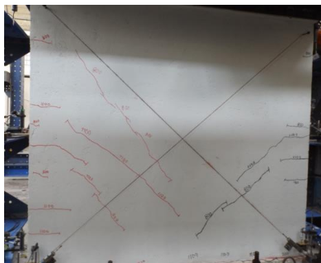
Foto 7. Aparición de más grietas en el muro y columnas (cara con reforzamiento) para la distorsión 1/800.
