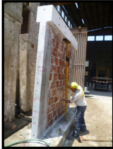
Figura 3.16. Apuntalamiento de viga solera y limpieza de unidades dañadas.
