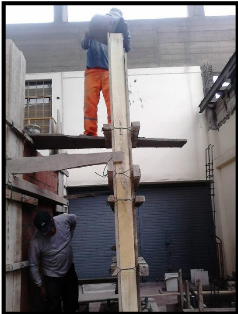
Figura 24. Vaciado de concreto
