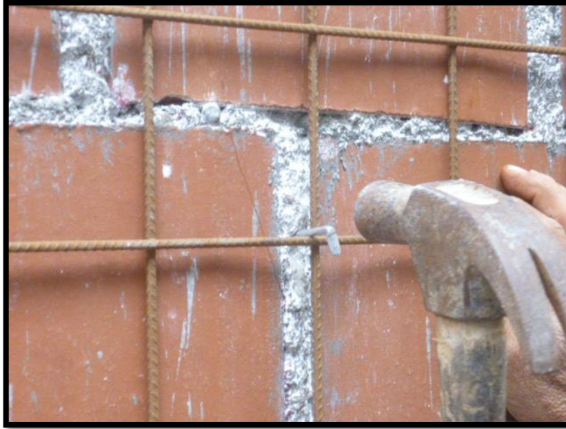
Figura 41. Colocación de aceros en muro para fijación de malla electrosoldada
