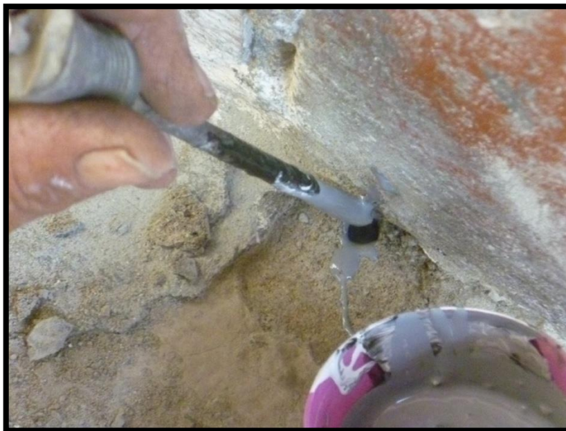
Figura 46. Colocación de mezcla epoxica
