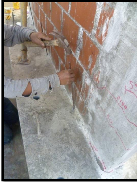
Figura 47. Colocación de aceros para anclaje de muro
