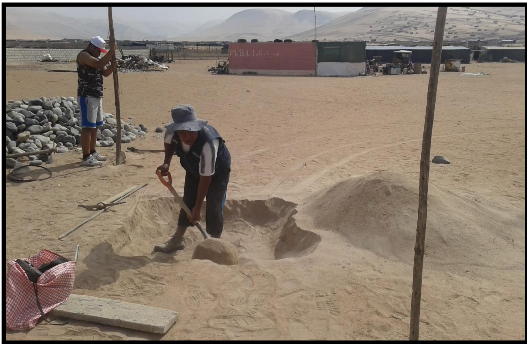
Fotografía 11. Excavación con herramientas manuales.
