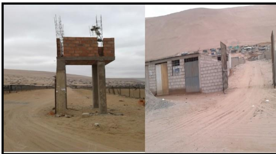
Figura 2. Construcción de columnas y vigas en la zona de estudio.
