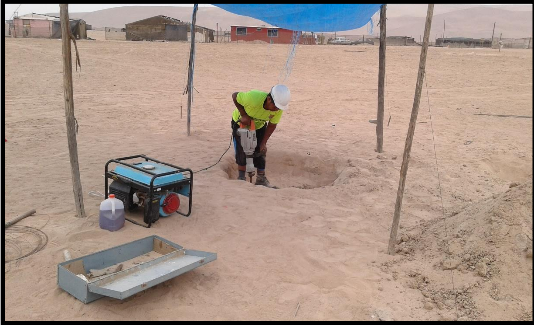
Fotografía 12. Excavación con martillo eléctrico.
