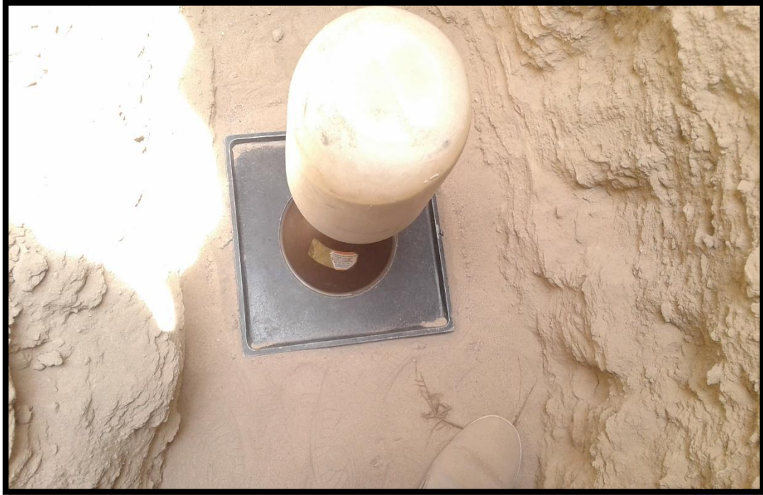
Fotografía 14. Ensayo densidad in-situ.
