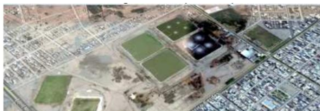
Figura Nro. 49 Vista fotográfica de la Planta COPARE
