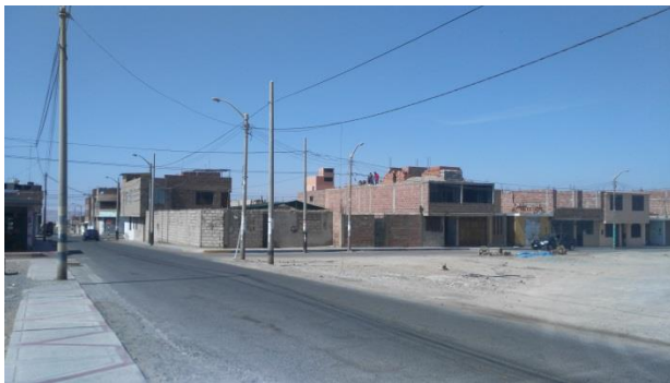
Figura 48: Vista hacia la calle Las Encinas
