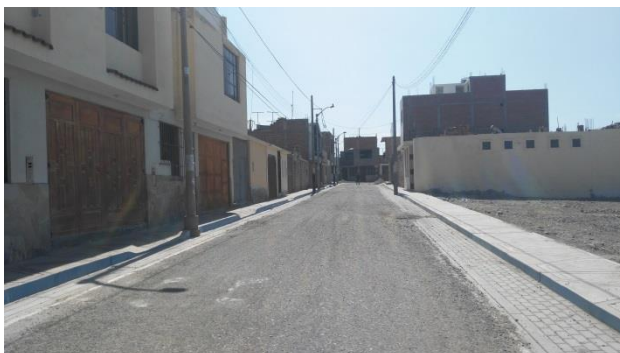
Figura 49: Vista hacia la calle José Cáceres Vernal
