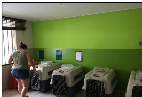
Figura 75. Paredes y techos
