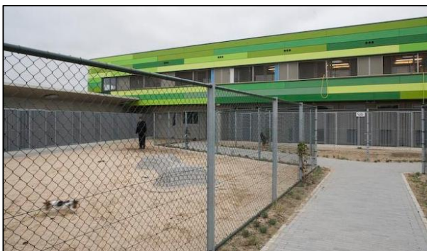
Figura 33. Respuesta a la humedad Fuente: Plataforma Arquitectura
