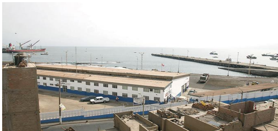
Figura 2: Instalación ENAPU Ilo
