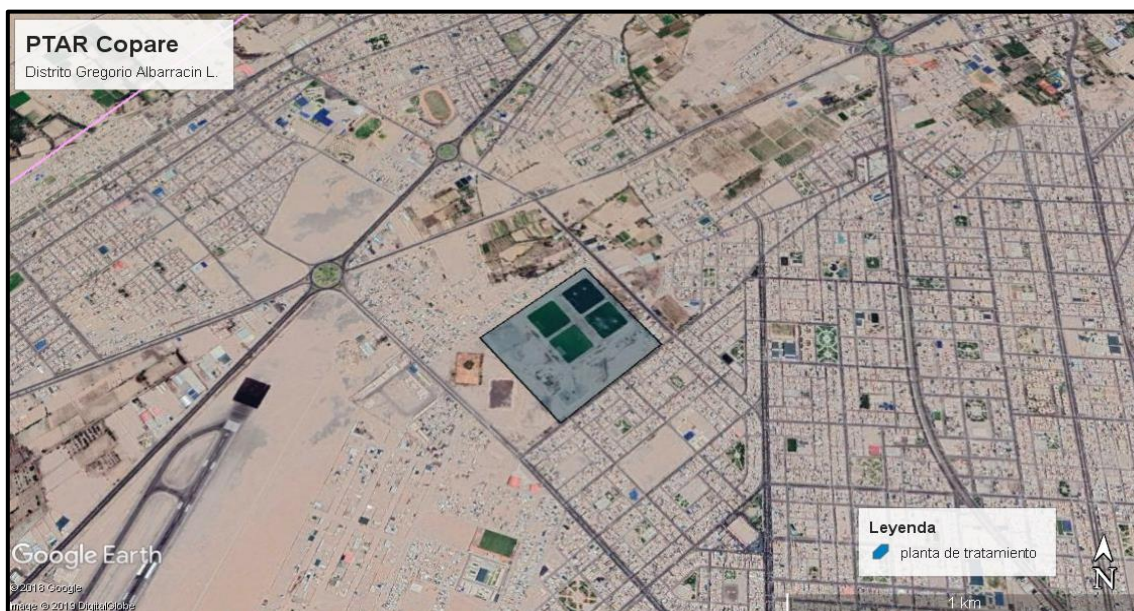
Figura N° 13: Ubicación de PTAR Copare
