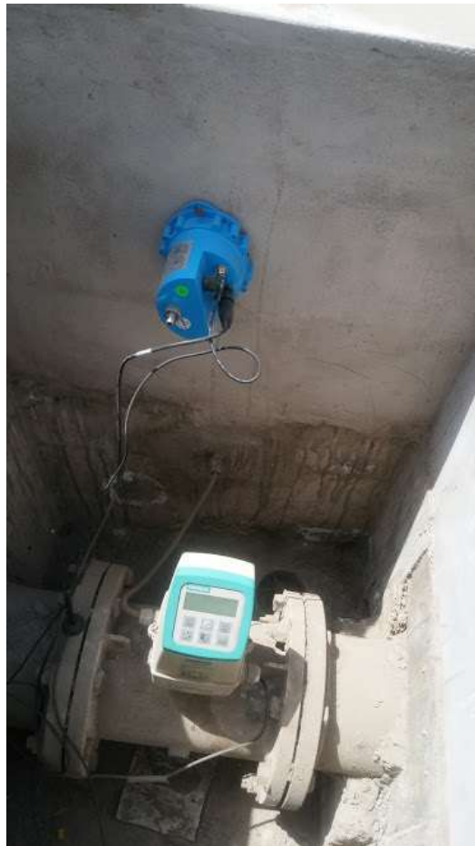
Macromedidor con equipo registrador Multilog Lx
