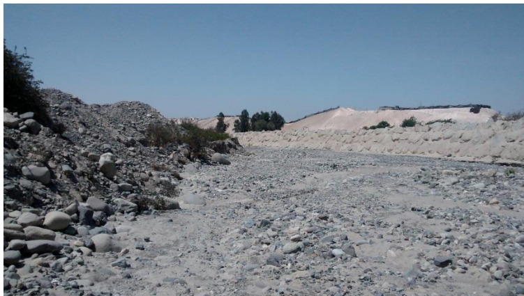
Figura 5. Material de fondo de cauce en la defensa de Calana. Se muestra el material del lecho de la defensa de Calana en la progresiva Km 0+000, se observa el dique enrocado en la margen derecha y el material del margen izquierdo
