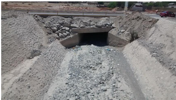
Figura 10. Vista del puente de la carretera Pachia-Calana
