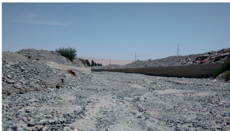
Figura 7. Inicio de sección de muros de concreto en la defensa de Calana. Aquí se observa la progresiva Km 0+560, donde se inicia el tramo con muros de concreto a ambos lados de la sección, también se ve el material del lecho.
