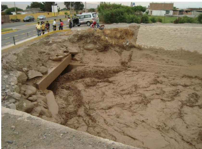
Figura 27. Río Caplina-río Seco en puente Calana-Pachía
