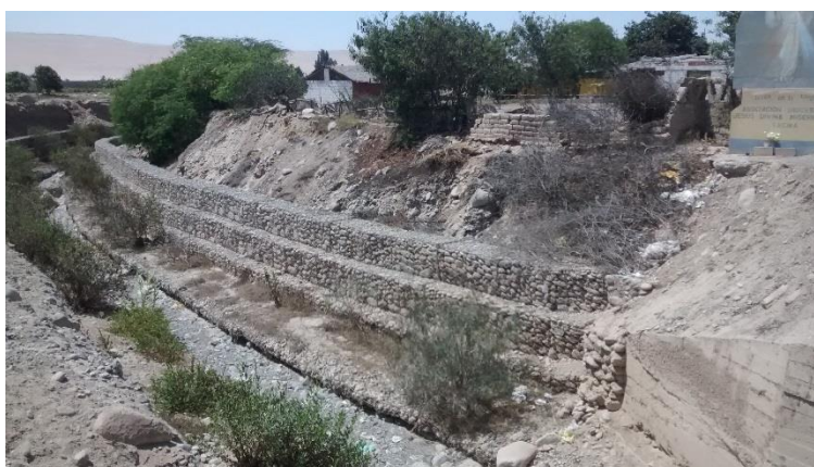
Figura 11. Gaviones aguas abajo del puente de la carretera Pachia-Calana
