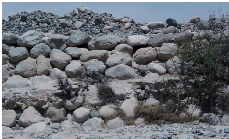
Figura 6. Dique Enrocado de la defensa de Calana progresiva Km 0+540
