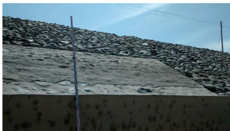
Figura 8. Inicio de sección compuesta en la defensa de Calana. Se observa el dique al margen derecho en la progresiva Km 0+940, fin sección de piedra emboquillada e inicio una sección de mampostería.
