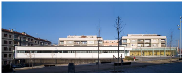
Figura 23. Fachada del Centro de Atención primaria Manresa
