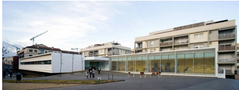
Figura 25. Vista posterior del Centro de Atención primaria Manresa
