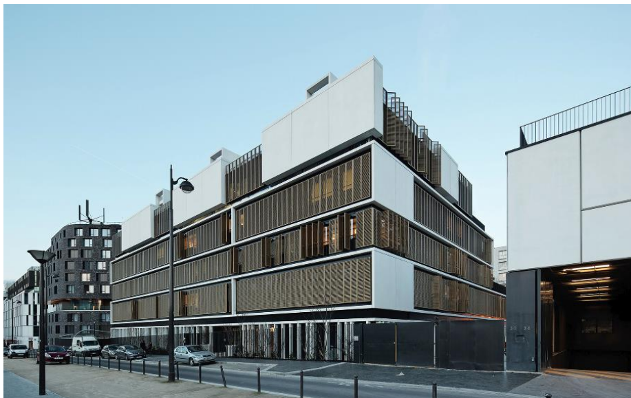
Figura 29. Fachada del Centro Bienestar
