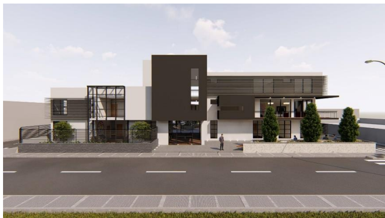
Figura 91. Fachada principal Nota: Fuente: Elaboración propia
