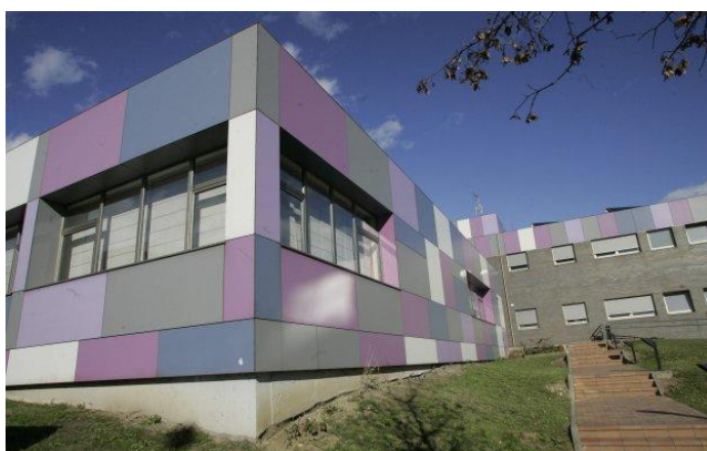
Figura 15. Fachada norte de la Casa Malva
