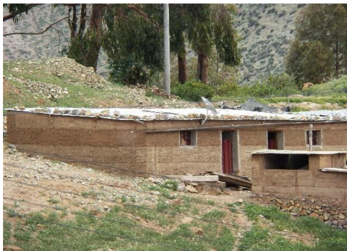
(Vivienda de tapial- foto visita de campo -2017)
