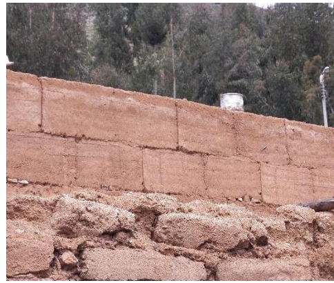
Uso del tapial Como sistema de construcción predominante
