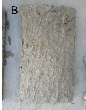
Revoque con 1% de cemento
