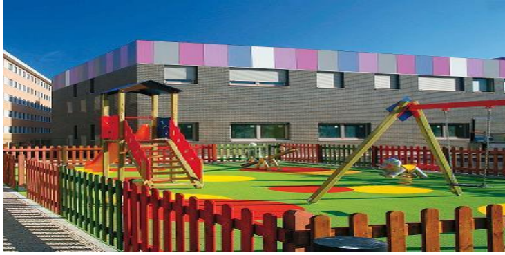
Figura 16. Edificio de Viviendas Tuteladas. Recuperado de: http://institutoasturianodelamujer.com/iam/violencia-de-genero/la-casa-malva/
