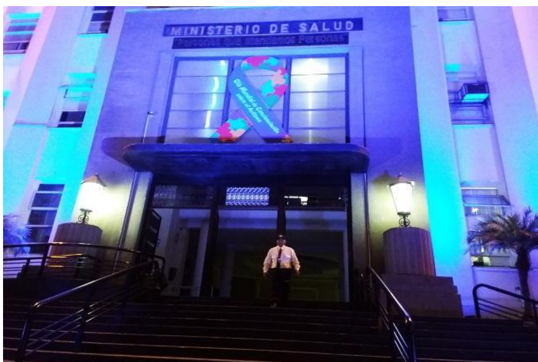
Figura 22: Iluminación de fachada
