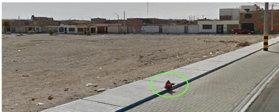
Figura 80: Vista de Hidrante en la Av. Los Historiadores
