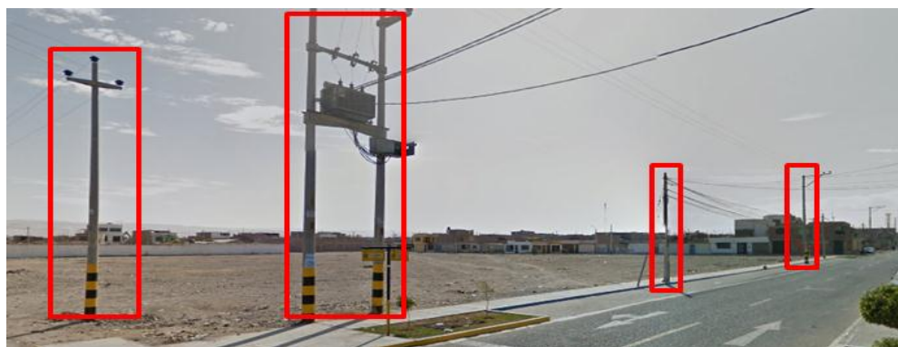
Figura 77: Vista del alumbrado público- Av. Los Historiadores
