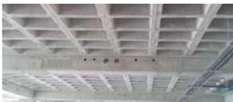
Figura 85: Losa nervada en dos direcciones
