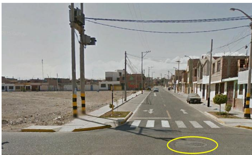
Figura 79: Vista de buzón de desagü
