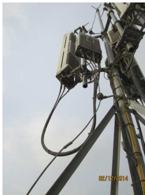
Foto 7: RRU + antenas + filtro instalados en torre
