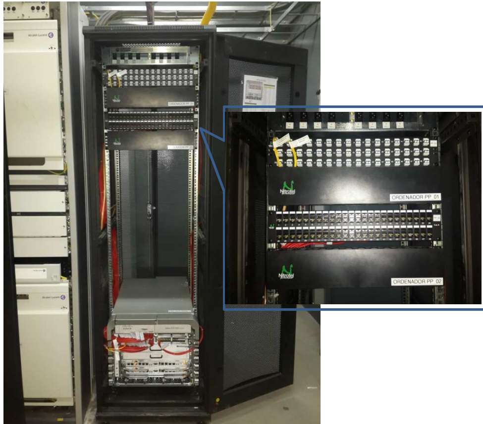
Foto 10: Equipo PE-RAN CISCO ASR 9006
