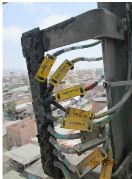
Foto 9: RRU aterradas a barra de tierra
