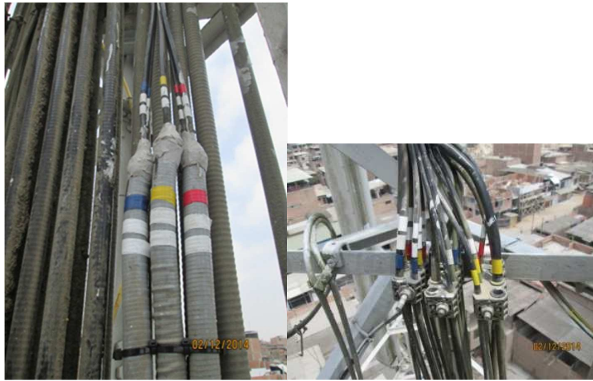
Foto 8: Recorrido en torre de cables de energía y fibra óptica
