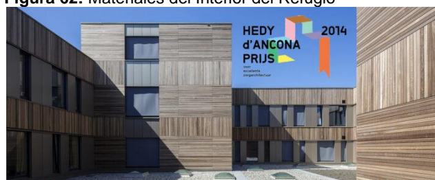
Figura 62: Materiales del Interior del Refugio
