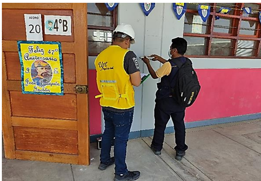
Figura 27 Toma de datos del ensayo para el primer nivel de la edificación
