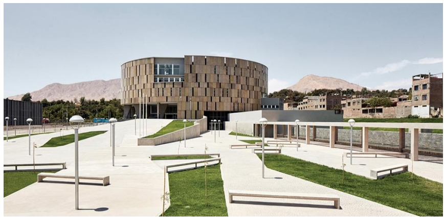
Figura 17: Vista desde la plaza del Gobierno Regional Moquegua
