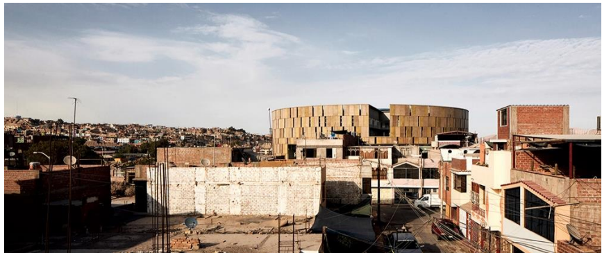
Figura 16: Vista del Gobierno Regional de Moquegua Fuente: Arquine.
