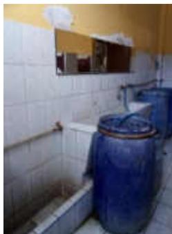
Ambas baterías de baño presentan desprendimiento de pintura en la parte superior del muro debido a la fluorescencia ocasionada por humedad adquirida a través filtraciones de lluvia. En otro punto, los muros de ambas baterías de baños se encuentran enchapados con cerámico hasta la altura de 1.80m, que al no tener una instalación sanitaria funcional se ha tornado de color oscuro debido a la aparición de agentes biológicos y patógenos, convirtiéndose en un área de riesgo infeccioso para la salud.
