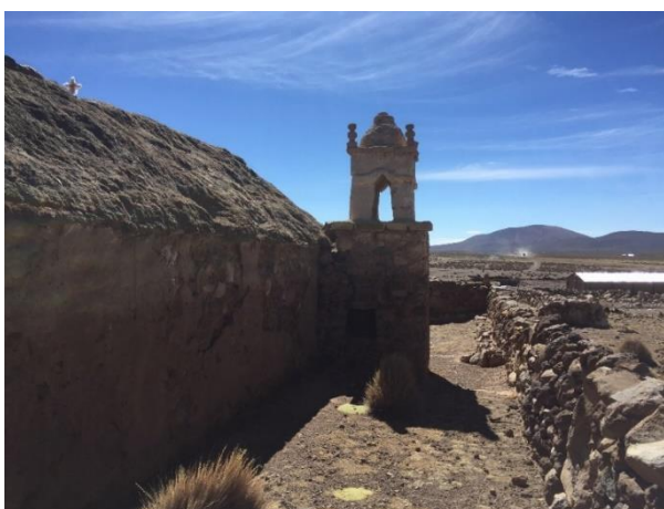
Figura 15. Deterioro del Patrimonio Inmueble
