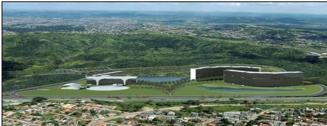
FIG.15- vista de conjunto del centro administrativo
