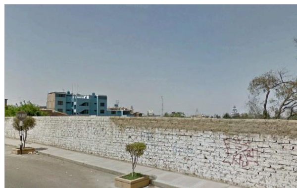
Imagen N° 91: Cerco perimétrico con bloque de adobe
