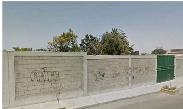
Imagen N° 90: Cerco perimétrico con bloquetas de concreto
