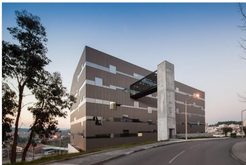
Imagen N° 44: Private Hospital Terra Quente
