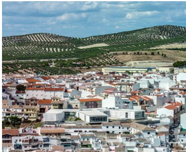
Imagen N° 23: Vista del emplazamiento de la tipología N° 02
