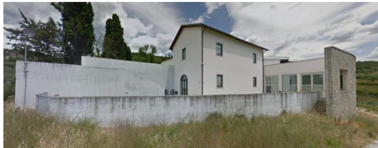
Imagen N° 19: Vista Peatonal del ingreso peatonal de la tipología N° 01
