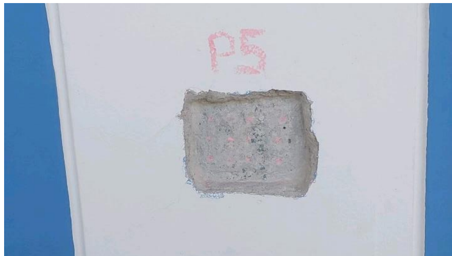
Figura 31 Picado del tarrajeo
