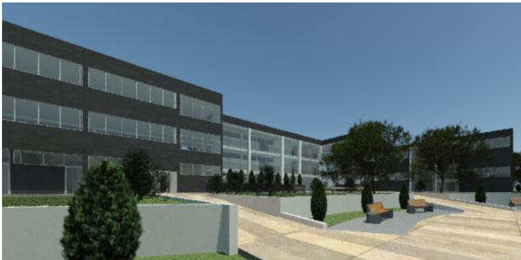
Figura 126. Vista Posterior Bloque A
