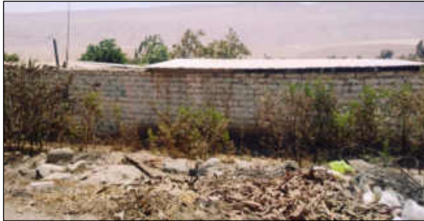
Figura 96: Estado de Conservación de edificaciones colindantes al Terreno de Estudio Fuente: Elaboración Propia
