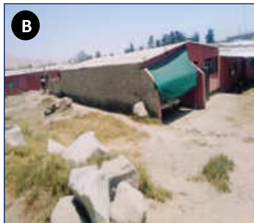
Figura 54: Parte Lateral Derecho del Terreno de Estudio Fuente: Elaboración Propia
