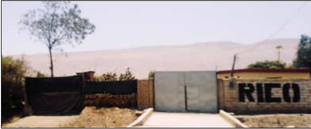
Figura 102: Muro Perimétrico de Adobe colindante al Terreno de Estudio Fuente: Elaboración Propia
