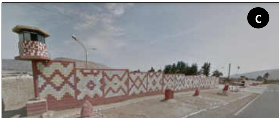
Figura 86: Se Ubica Cuartel Miculla Fuente: Elaboración Propia
