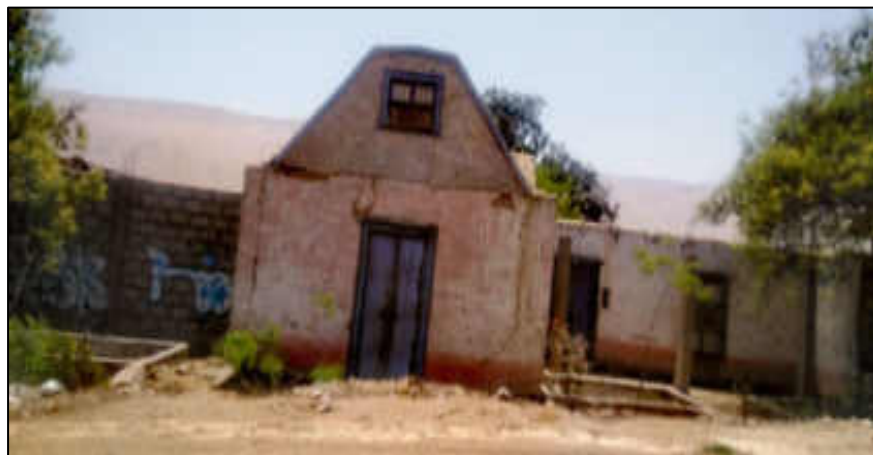
Figura 97: Estado de Conservación de edificaciones colindantes al Terreno de Estudio Fuente: Elaboración Propia
