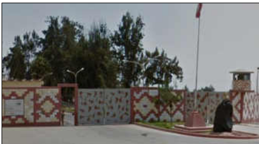
Figura 99: Estado de Conservación de edificaciones colindantes al Terreno de Estudio Fuente: Elaboración Propia
