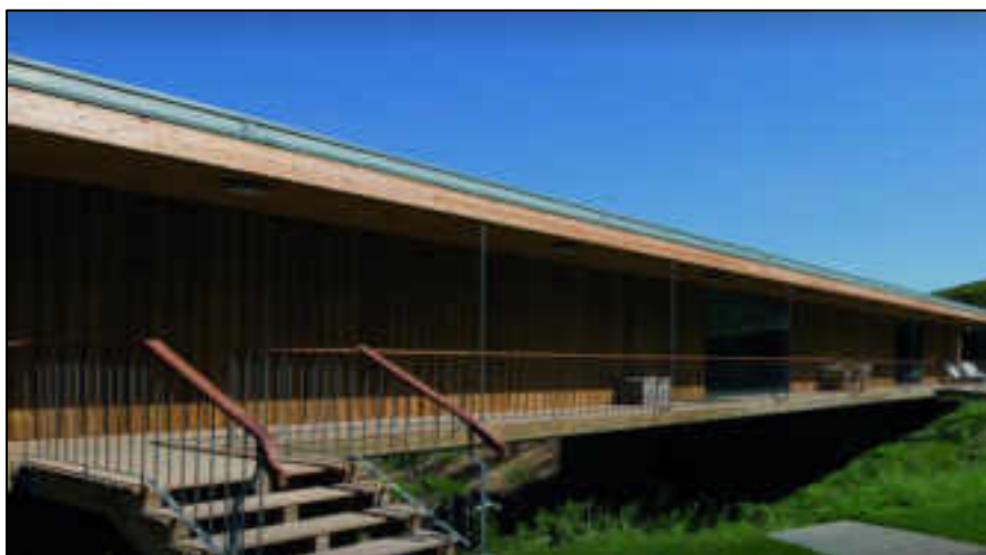
Figura 32: Hotel Rural Casa do Rio – Sistema Funcional, Vista Frontal
