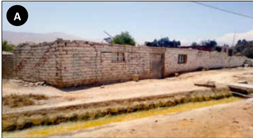
Figura 84: Se ubica viviendas y el Canal Caplina Fuente: Elaboración Propia
