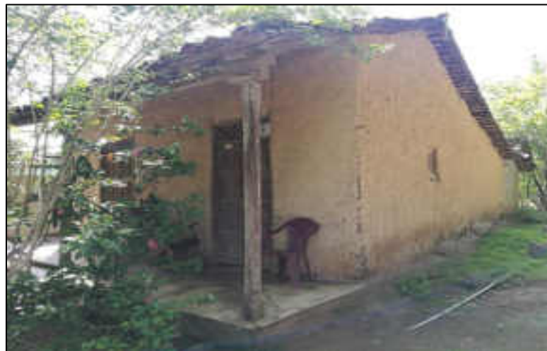
Figura 104: Vivienda de Quincha colindante al Terreno de Estudio Fuente: Elaboración Propia
