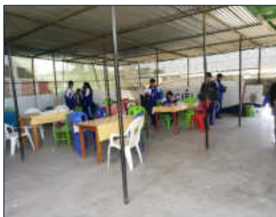
Grafico N°05 - Infraestructura existente nivel secundario comedor
