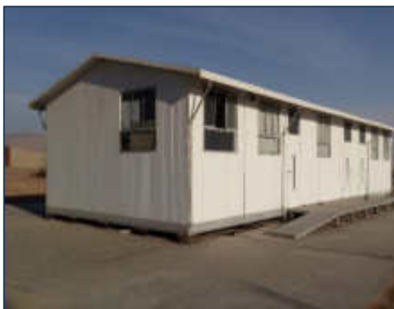
Grafico N° 04 - Infraestructura existente nivel secundario usos múltiples
