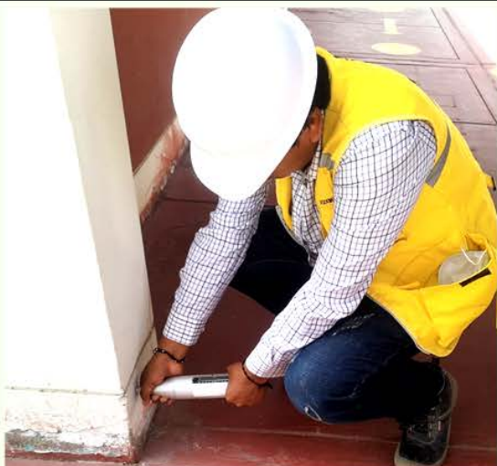
Imagen 02. Ensayo con esclerómetro - Columna 1
