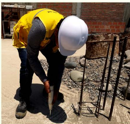
Imagen 03. Ensayo con esclerómetro - Viga 1
