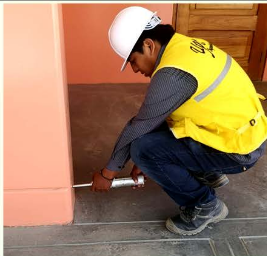
Imagen 03. Ensayo con esclerómetro - Columna 2
