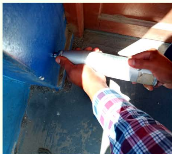
Imagen 03. Ensayo con esclerómetro - Columna 2
