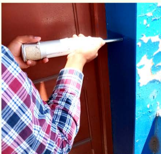
Imagen 02. Ensayo con esclerómetro - Columna 1
