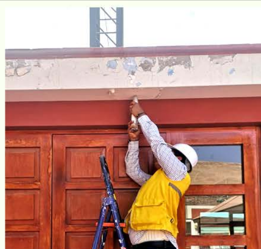
Imagen 04. Ensayo con esclerómetro - Viga 2
