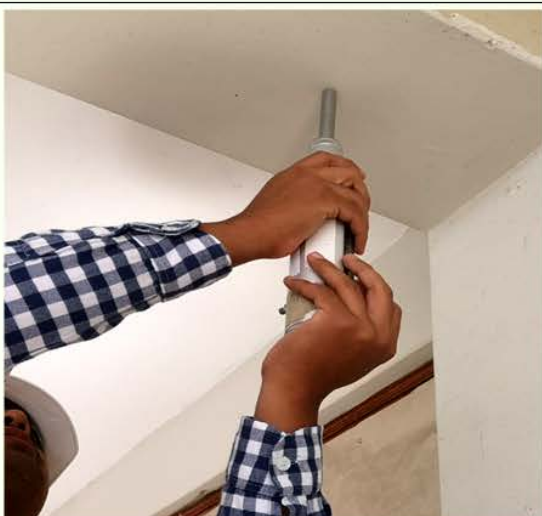
Imagen 03. Ensayo con esclerómetro - Viga 1
