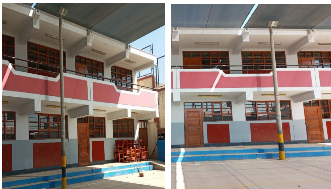
Pabellones analizados de la I.E. Simón Bolívar
