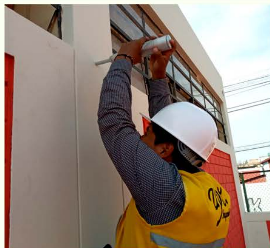
Imagen 03. Ensayo con esclerómetro - Columna 2
