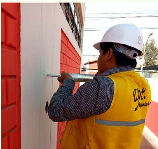
Imagen 02. Ensayo con esclerómetro - Columna 1
