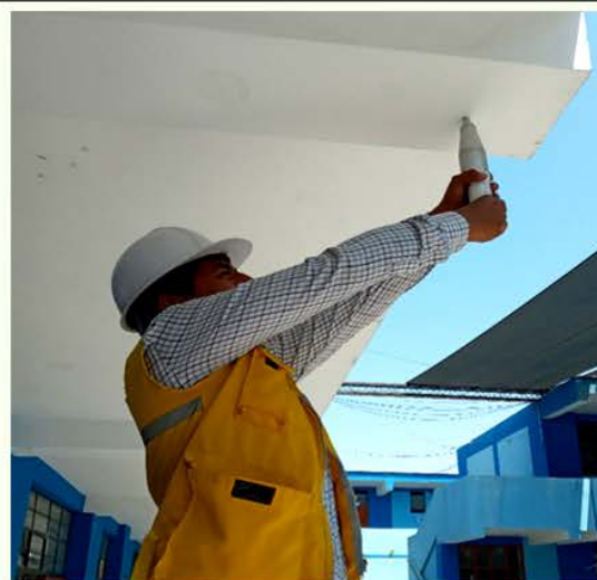
Imagen 04. Ensayo con esclerómetro - Viga 2
