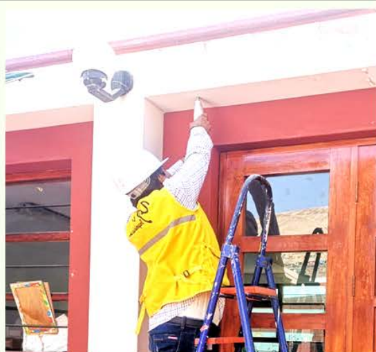
Imagen 03. Ensayo con esclerómetro - Viga 1
