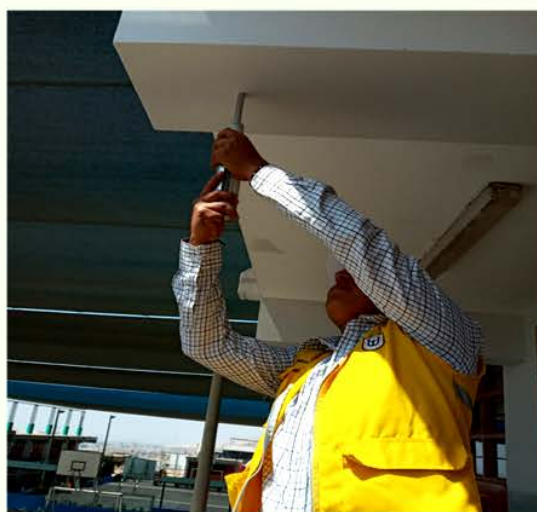
Imagen 04. Ensayo con esclerómetro - Viga 2
