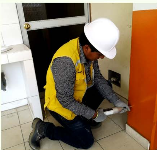
Imagen 02. Ensayo con esclerómetro - Columna 1
