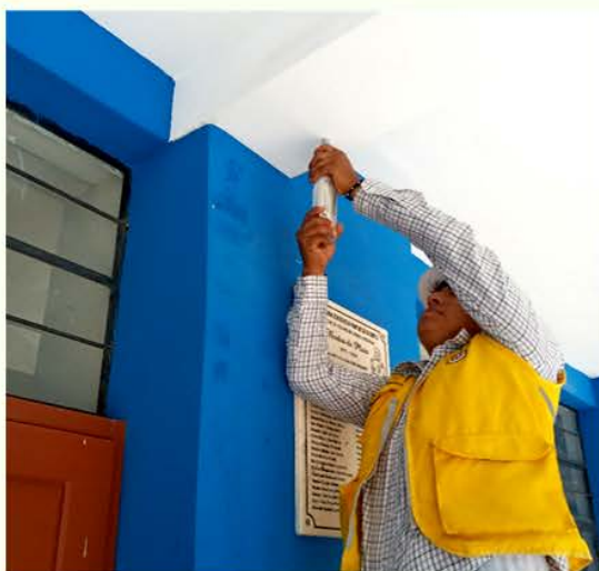
Imagen 03. Ensayo con esclerómetro - Viga 1
