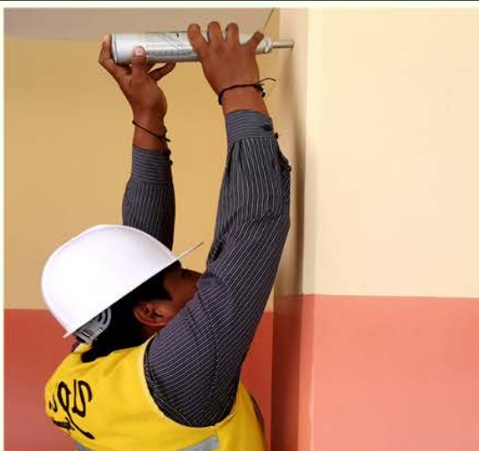
Imagen 02. Ensayo con esclerómetro - Columna 1
