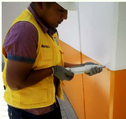
Imagen 03. Ensayo con esclerómetro - Columna 2
