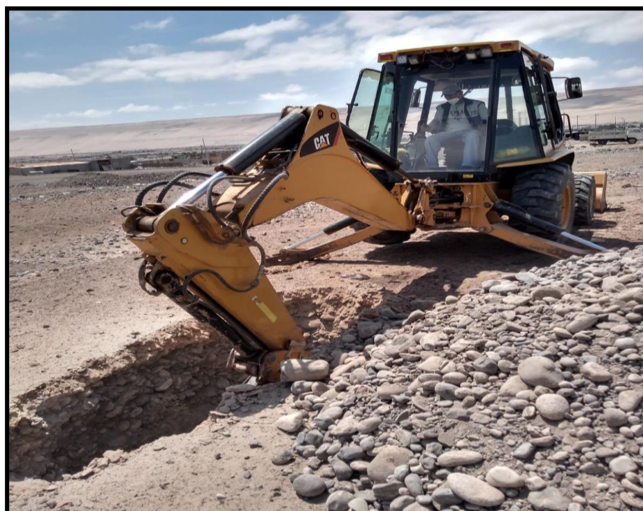
Fotografía 18: Maquinaria realizando la excavación en la Calicata C – B del sector 12 San Antonio.
