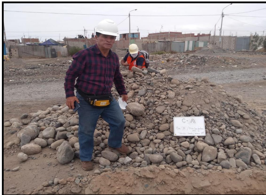
Fotografía 14: Realización de la calicata C – A en el sector 12 San Antonio.
