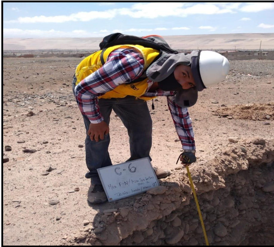
Fotografía 13: Corroborando la altura de la calicata C – 6 con wincha de 5m.
