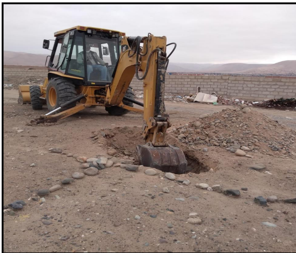
Fotografía 7: Maquinaria realizando la excavación en la Calicata C – 3 del sector 12 San Antonio.
