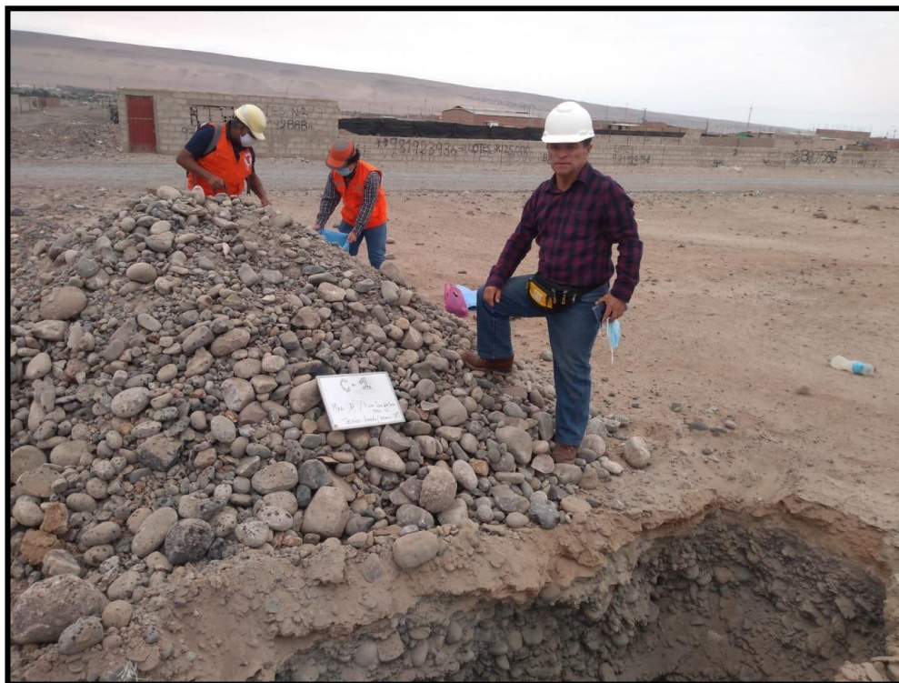
Fotografía 1: Realización de la calicata C – 1 en el sector 12 San Antonio
