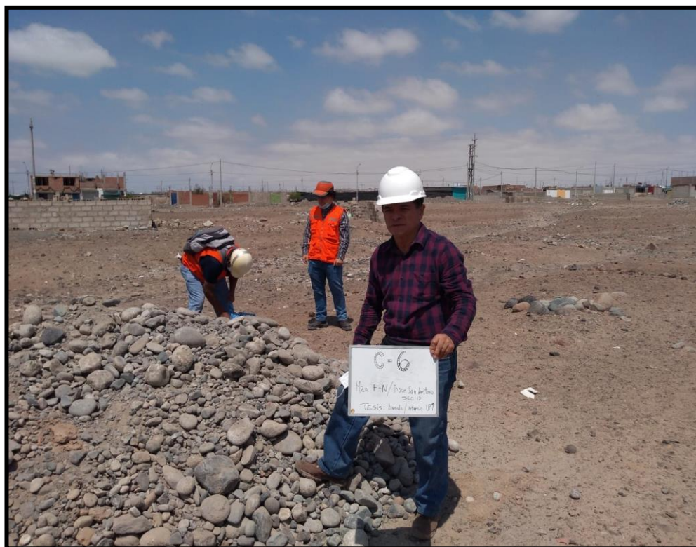
Fotografía 11: Realización de la calicata C – 6 en el sector 12 San Antonio.
