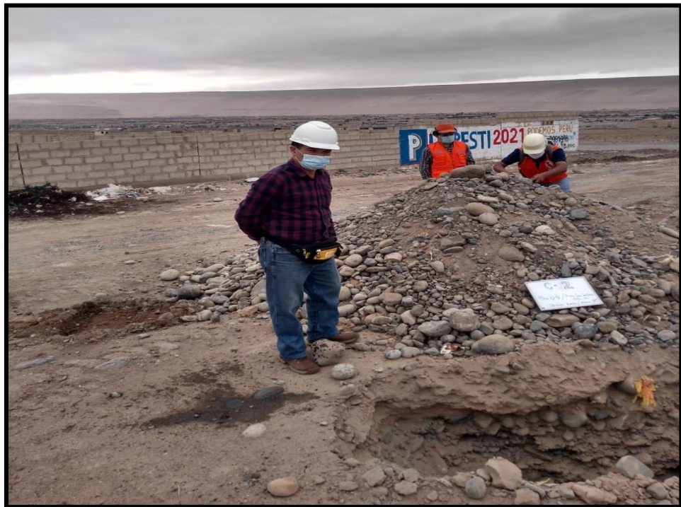
Fotografía 4: Realización de la calicata C – 2 en el sector 12 San Antonio.
