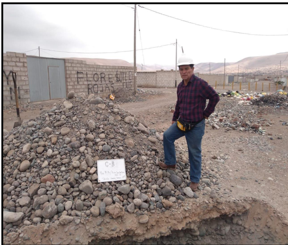
Fotografía 17: Realización de la calicata C – B en el sector 12 San Antonio.
