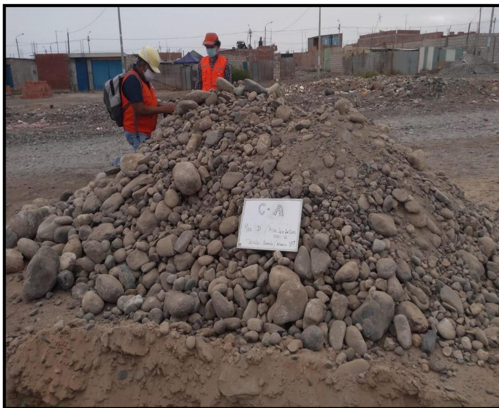
Fotografía 15: Realización de la calicata C – A en el sector 12 San Antonio.
