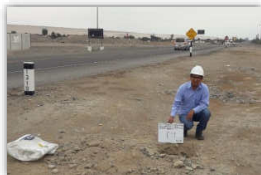
FIGURA N° 2: Toma de muestra progresiva KM 1310+00
