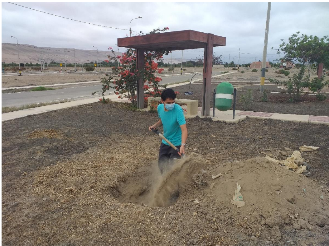
Figura 29 Realizando la Calicata
