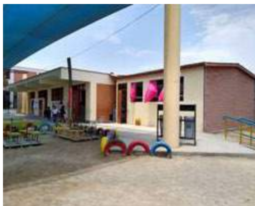
Figura 55. Vista de la zona de inicial.
