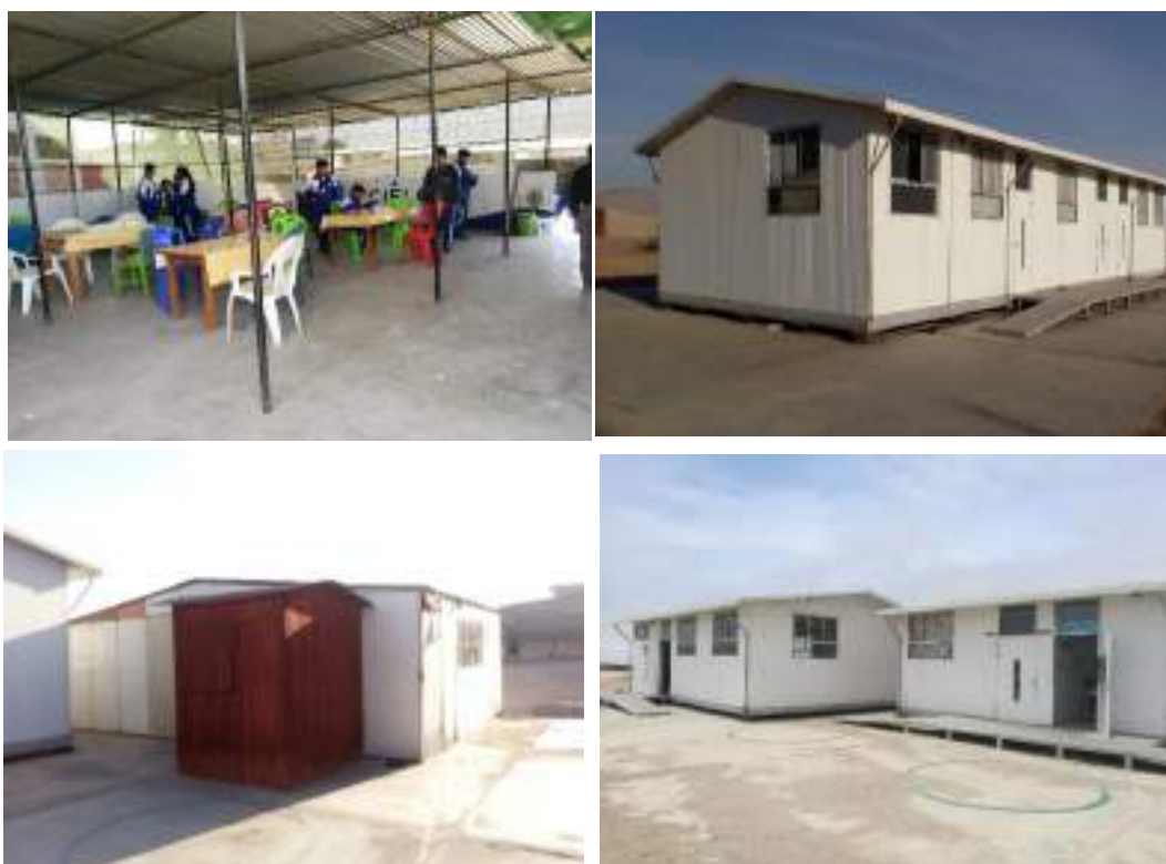
Figura 63. Vista de los bloques con material prefabricado.
