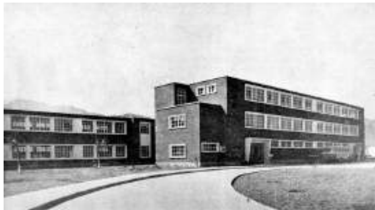
Figura 6. Fachada Gran Unidad Escolar Ricardo Bentín.
