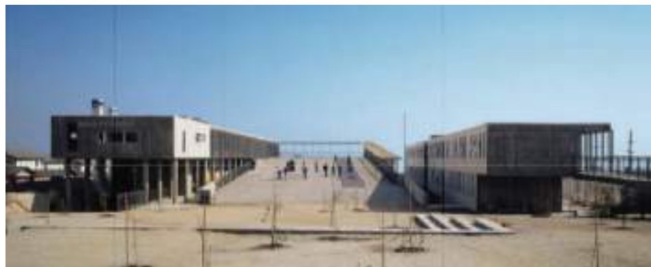
Figura 34. Fachada principal del colegio Altamira.
