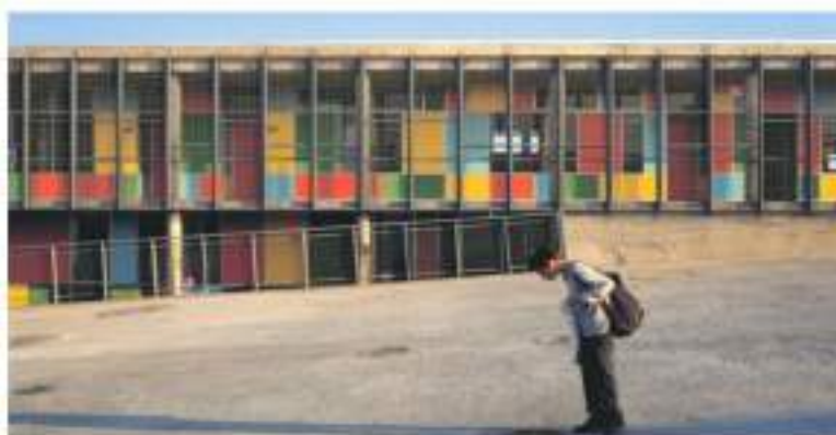
Figura 37. Vista posterior del colegio Altamira.
