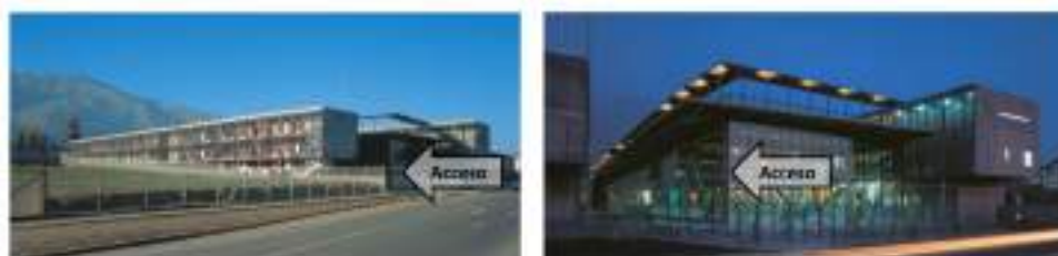
Figura 33. Vistas frontales del colegio Altamira.
