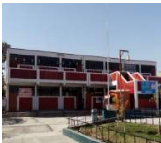
Figura 59. Vista frontal del bloque A
