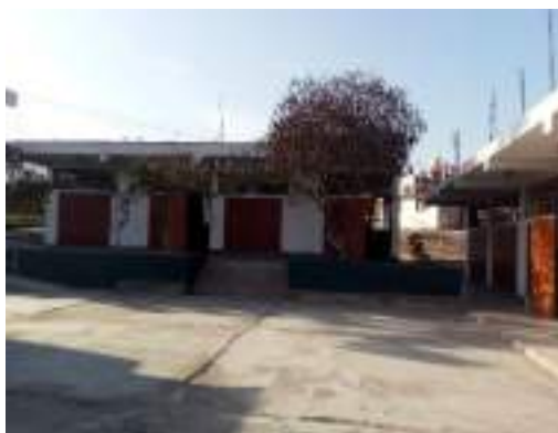
Figura 62. Vista Frontal del bloque E y F
