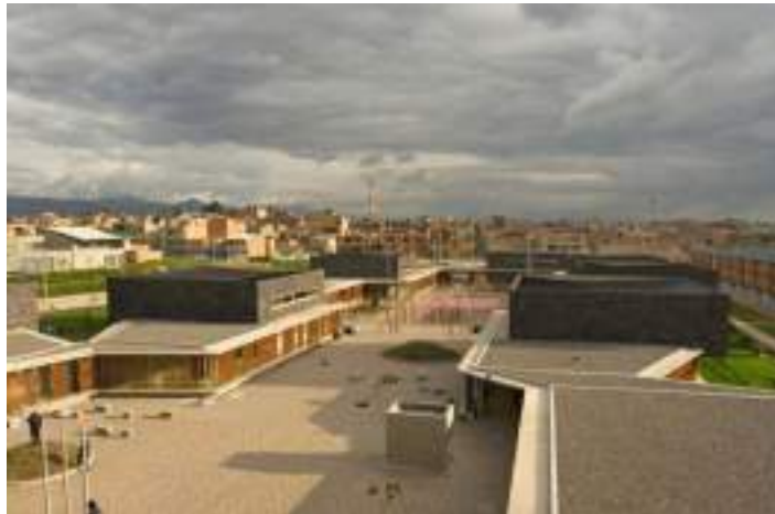
Figura 46. Vista área del patio principal del colegio Gerardo Molina.
