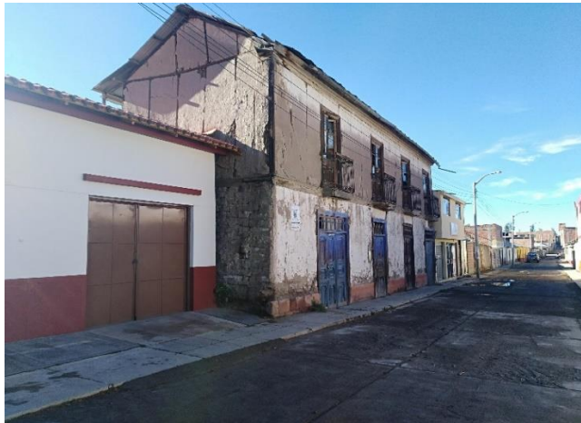
Figura 72: Casona de adobe - Casa García Hennig Fuente: Elaboración propia
