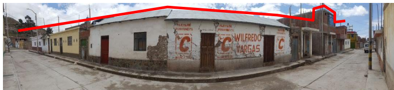
Figura 70: Tipología de vivienda predominante en el Distrito de Candarave (un nivel)
