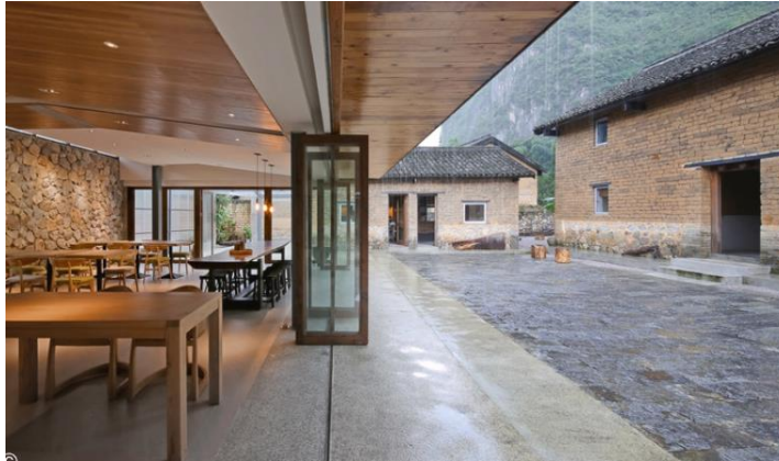
Figura 56: Tecnología constructiva y remodelación de la Casa Yun Eco-Resort Boutique
