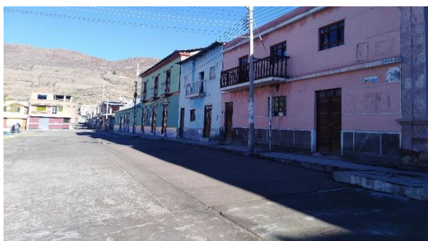
Figura 76: Estado de la vía del Casco urbano
