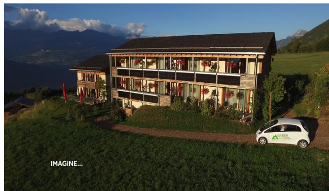
Figura 32: Vista de vía de acceso al Hotel ecológico de paja “Maya”
