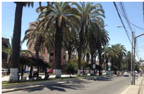
Figura 101: Vista del Segundo Tramo, no se observan rampas, ni entre la caminería principal y la vereda, ni la vereda y la pista, ni la pista con la vereda de enfrente.
