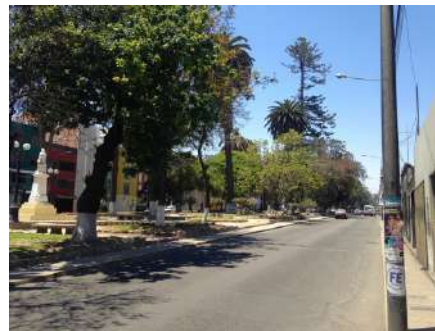
Figura 102: Vista del parque, no se observan rampas, ni entre la caminería y la vereda, ni la vereda y la pista, ni la pista con la vereda de enfrente.
