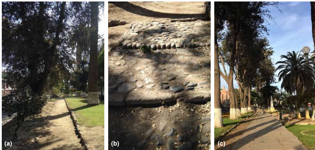
Figura 96: Vista (a) de caminería en tierra y piedra de cantería en sardinel. Vista (b) de la piedra apisonada y tierra de ingresos, así como piedra de cantería. Vista (c) de caminería en concreto
