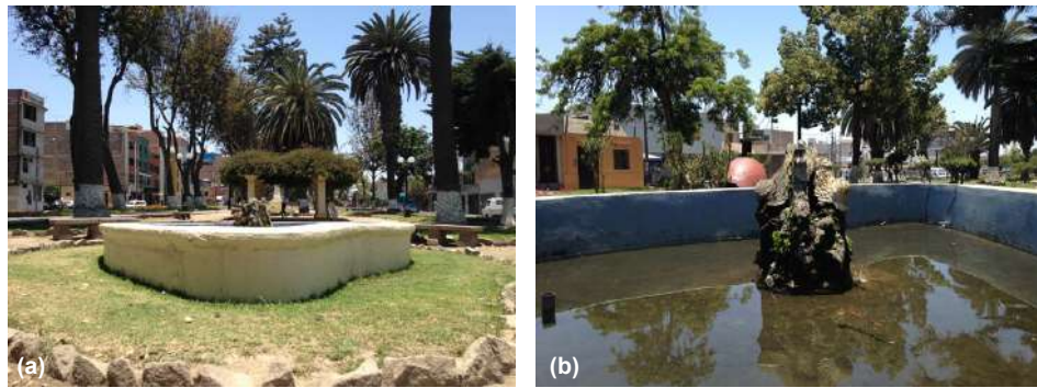
Figura 75: En la figura (a) se observa la fuente corazón y sus alrededores, mientras que en la figura (b) se muestra el interior de la misma, así como su dispensador de agua con la escultura de los cisnes partidos y el agua estancada.
