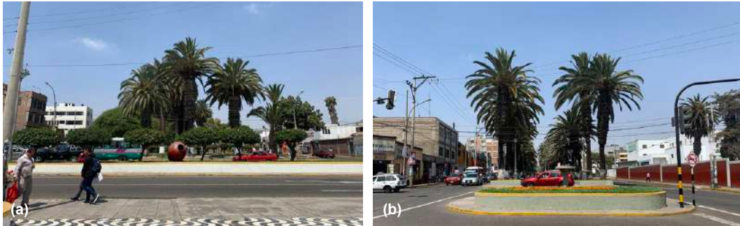
Figura 94: Vista (a) de la isla peatonal de la prolongación de la calle Arica. Vista (b) de la isla peatonal de la prolongación de la calle Billinghurst
