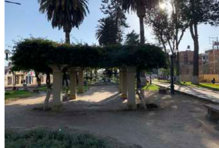
Figura 33: Desniveles internos, mal estado de mobiliario urbano
