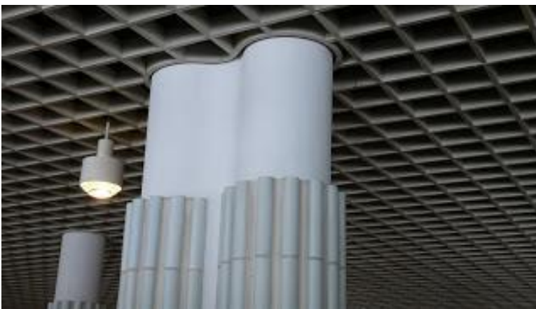
Figura 41. Visa Interior del Auditorio Principal y de las columnas
