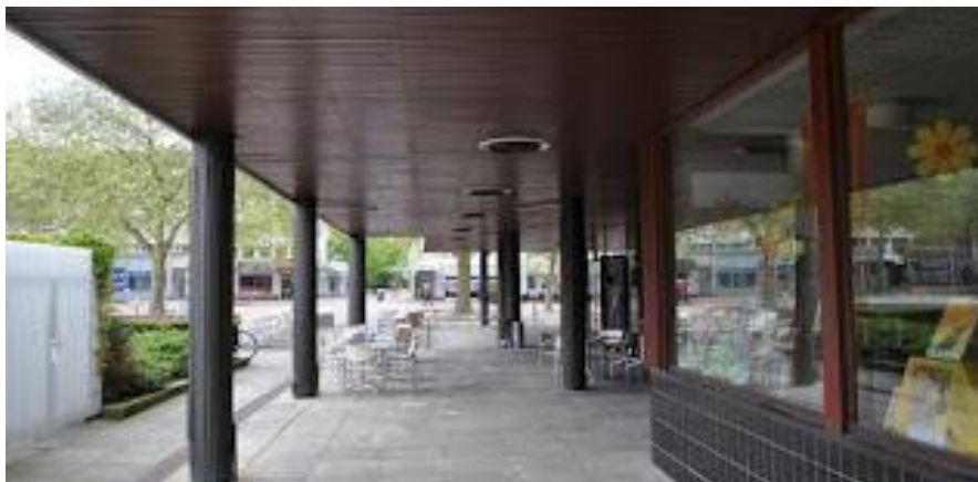
Figura 37 .Vista del pasillo principal del Centro Cultural
