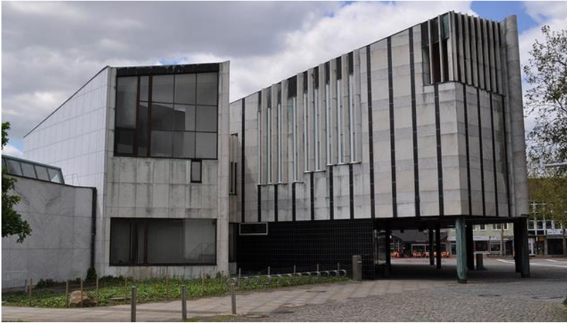
Figura 34 .Vista Frontal Este del Centro Cultural de Wolfsburg
