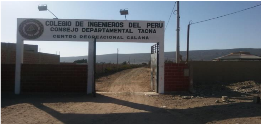
Figura 21 .Fotografía actual del Ingreso Principal CIP Tacna
