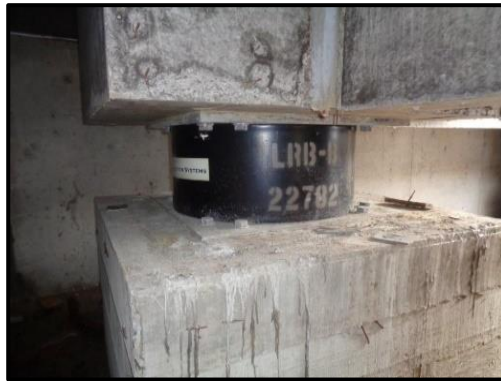
Figura N° 19: Aislador elastomérico con núcleo de plomo (LRB)
