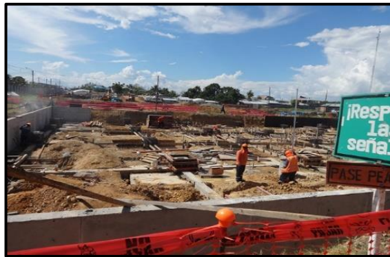
Figura N° 20: Construcción de Hospital Santa Gema de Yurimaguas
