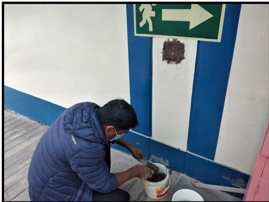
*Resane de columnas con recubrimiento de mezcla de cemento*
