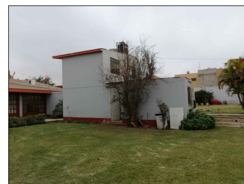
4. Vista del bloque de servicios
