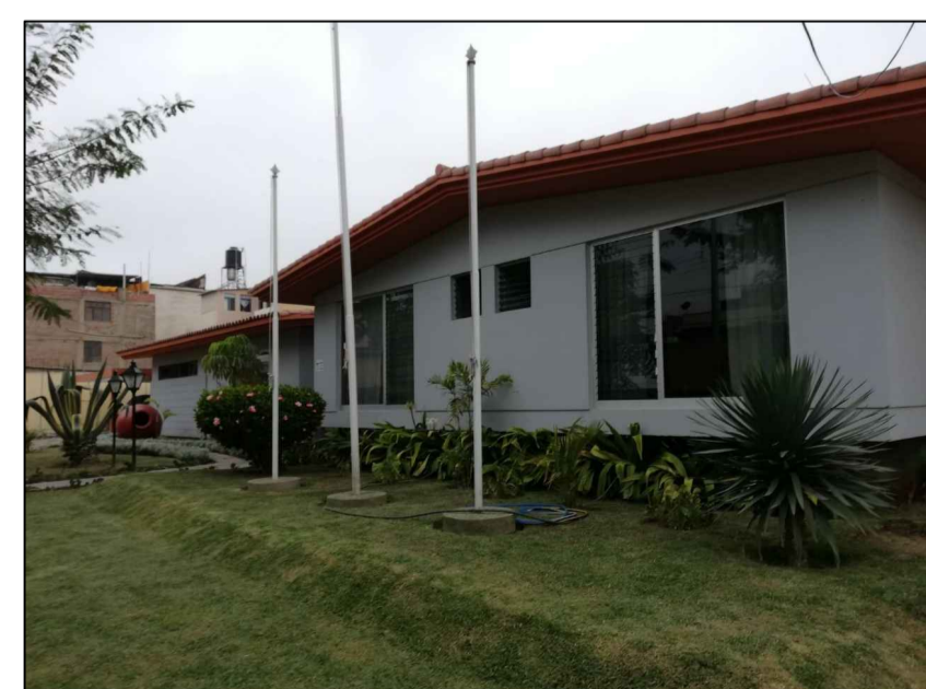
1. Vista de la Fachada Principal de la Casona 1
