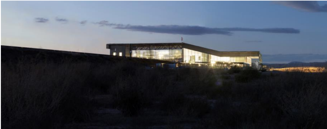
IMAGEN 51: Exterior - Estación de alta velocidad de Villena.
