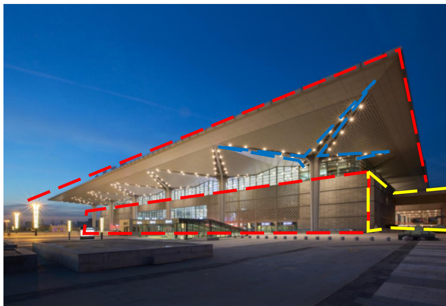
IMAGEN 27: Estación de tren Taiyuannan.
