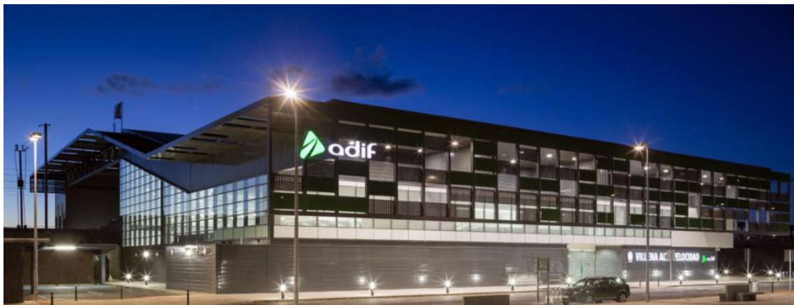
IMAGEN 49: Exterior - Estación de alta velocidad de Villena.
