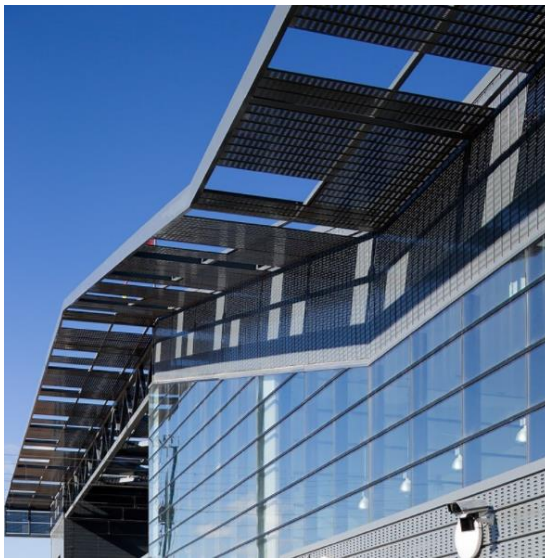
IMAGEN 52: Exterior - Estación de alta velocidad de Villena.
