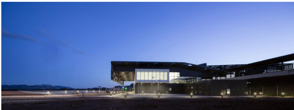
IMAGEN 50: Exterior - Estación de alta velocidad de Villena.
