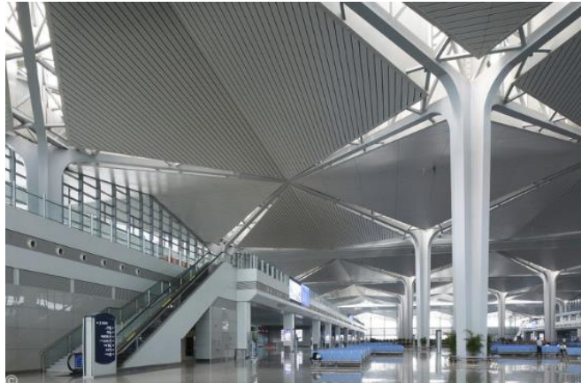
IMAGEN 30: Estación de tren Taiyuan - interior.
