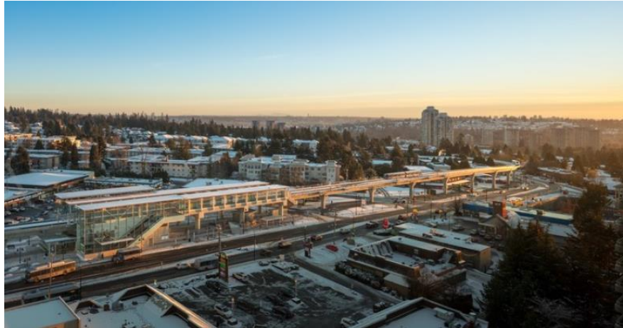
IMAGEN 04: Estación Línea Evergreen, Coquitlam, Bc, Canadá
