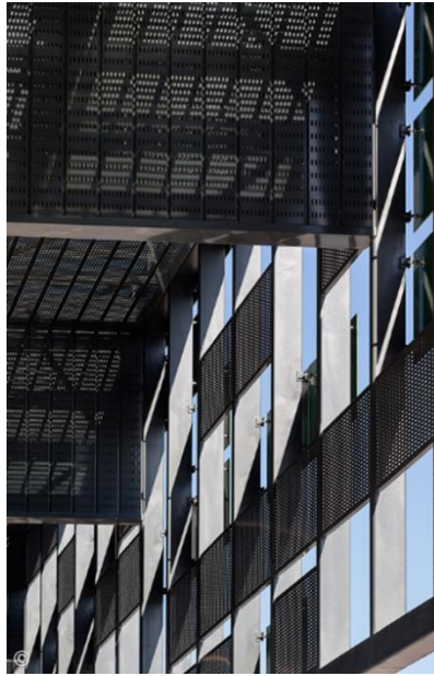
IMAGEN 45: Cubierta - Estación de alta velocidad de Villena.
