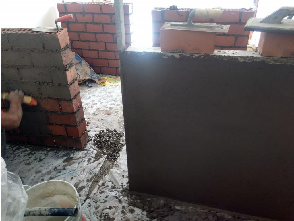
FOTO N°14: PARTE DE LOS MURETES YA CONSTRUIDOS, PARA SOMETERLOS A ENSAYOS.
