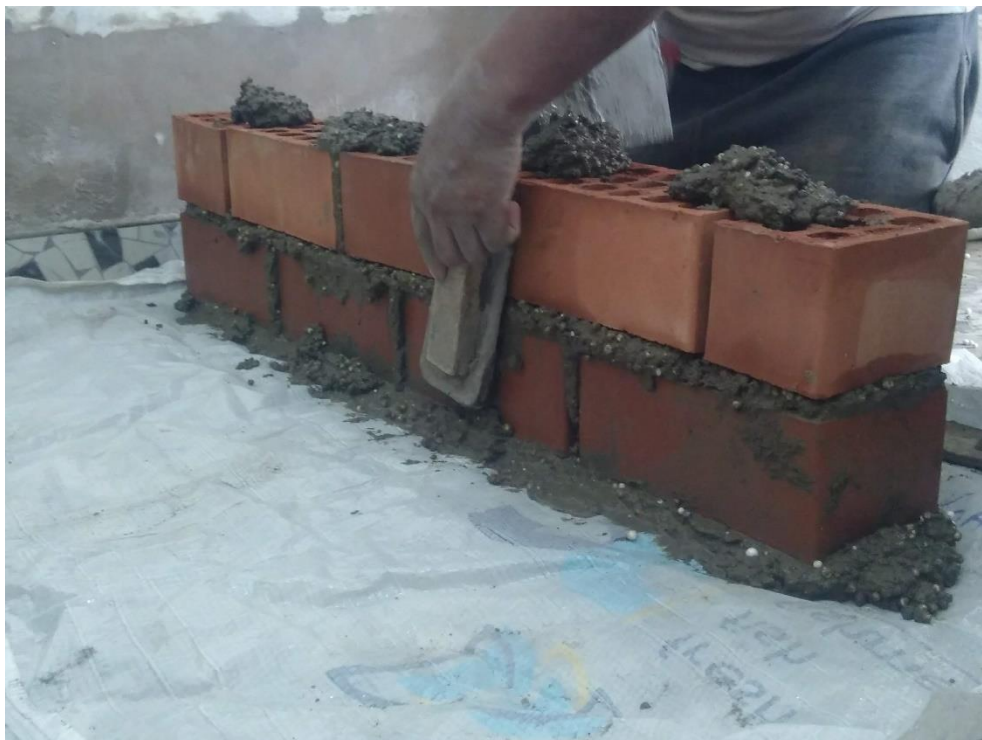
FOTO N°12: ASENTADO DE LOS MURETES DE 1.00x1.00m, EN ESTE CASO SE HA USADO PERLAS DE POLIESTIRENO EXPANDIDO.
