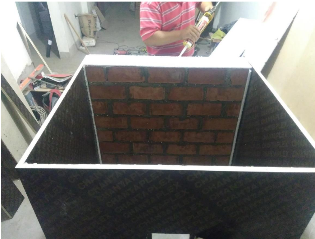
FOTO N°15: SIMULACION DE UN AMBIENTE EN UNA EDIFICACION, FORMANDO UN CUBO CON MAPRESA, POR LA DUREZA DEL MATERIAL.
