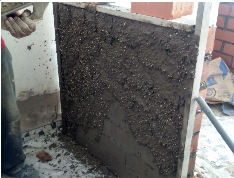
FOTO N°13: SE HA TRABAJADO TAMBIÉN EL TARRAJEO, EN ESTE CASO SUSTITUYENDO LA PROPORCION DE 1:5 PARA EL TARRAJEO.
