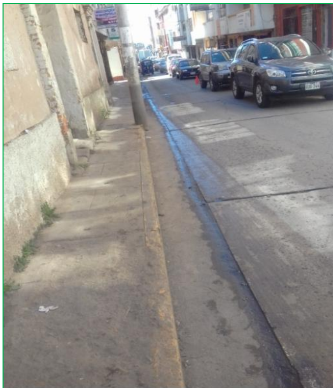
Figura 21. Jr. Cajamarca Fuente: Elaboración propia
