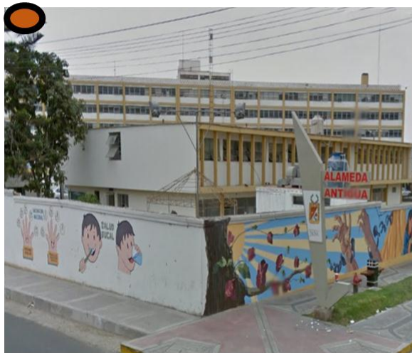
El hospital mantiene una cercanía directa, este representa un hito importante por la magnitud de su infraestructura y el significado que tiene para la ciudad de Tacna.
