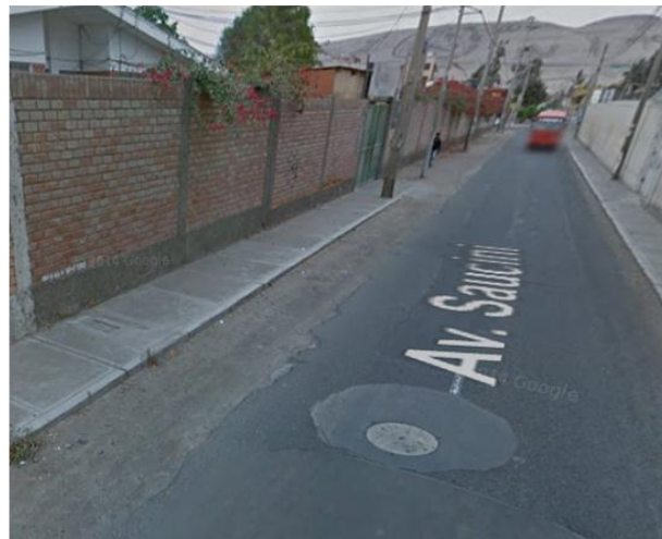
Existen 4 buzones de desagüe, 3 en la AV. Gregorio Albarracín y 1 en la Av. Leguía.
