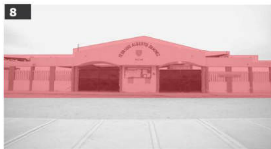
8 I.E. Dr. Luis Alberto Sánchez Estado: Regular Cuenta con niveles de educación inicial, primaria y secundaria. Actualmente, se halla en ejecución la obra de ampliación y mejoramiento de la institución.
