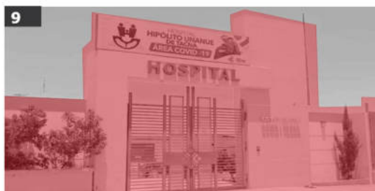
9 Pronis Hospital Hipólito Unanue Estado: Regular Actualmente, se halla en estado de abandono, solo funcionó en el período de la pandemia. No posee saneamiento físico legal. Posee infraestructura provisional.
