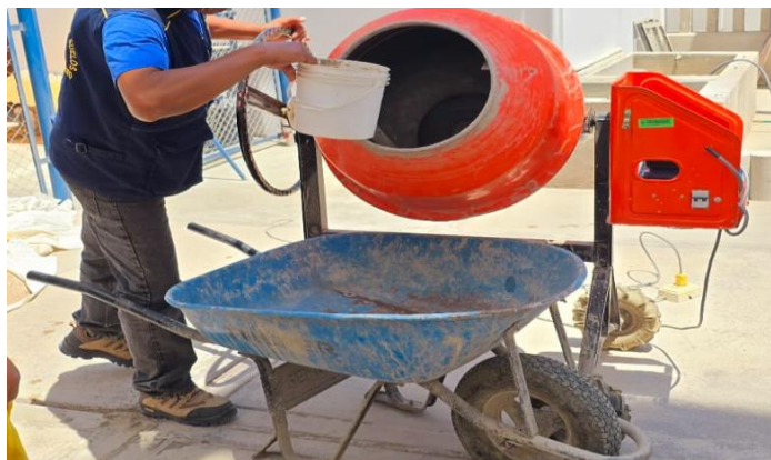
Figura 55 Elaboración y Curado del concreto – Humedecimiento de los equipos
