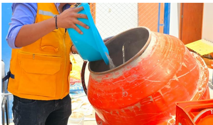
Figura 56 Elaboración y Curado del concreto – Se introducen los materiales
