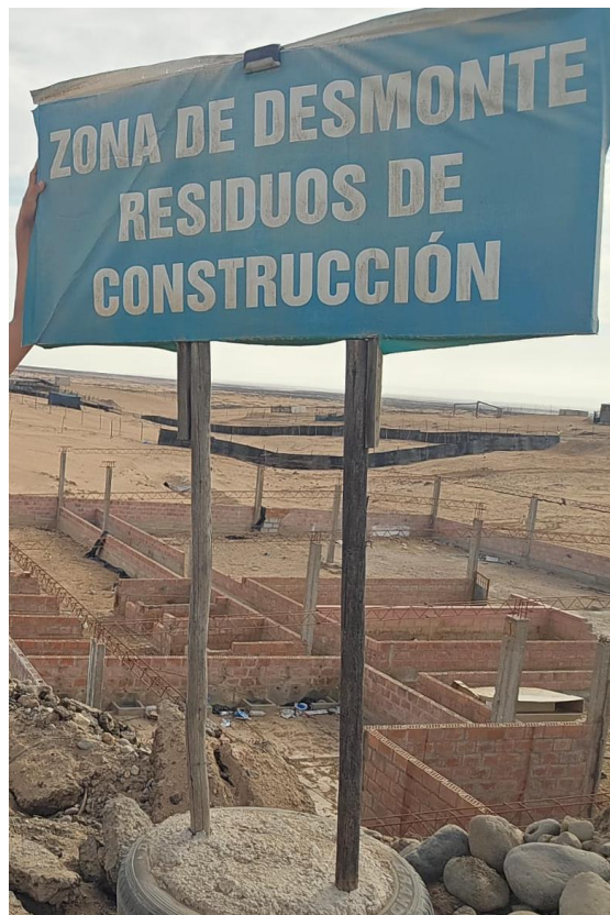
Figura 2 Ubicación de residuos de construcción en el DME
